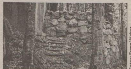
Das eigene Wasserwerk...
