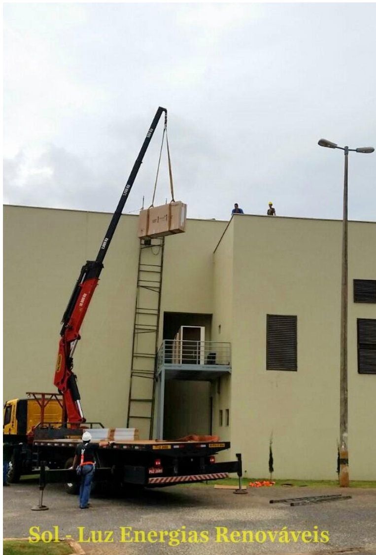
Figura 10 - Instalação do sistema solar fotovoltaico da Igreja do Rosário
