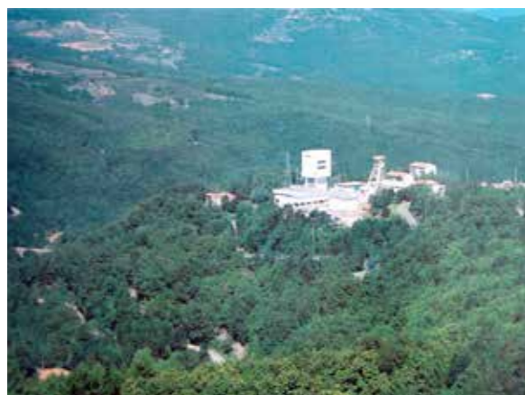
Foto 4. Miniera di Campiano. Il Pozzo 1 (a sinistra), il Pozzo 2 e parte degli impianti esterni.
