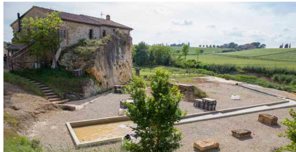
Foto 4. La sorgente dell'Acqua Borra è attualmente completamente artificializzata: il piazzale circostante è stato coperto con breccia calcarea e le acque sorgive sono state captate, riversate in una vasca in muratura e canalizzate fino al vicino Fosso Malena. Interventi di questo tipo alterano in modo irreversibile questi siti il cui valore scientifico e conservazionistico è evidenziato dalla presenza di habitat e di specie di interesse comunitario. Per questo motivo andrebbe urgentemente considerato un intervento di ripristino per recuperare almeno alcune delle originarie caratteristiche di naturalità (© Giovanni Cappelli).
