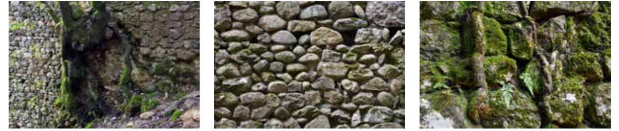
Cinta muraria, esempi della situazione delle murature (foto Adriano Paoletta).
