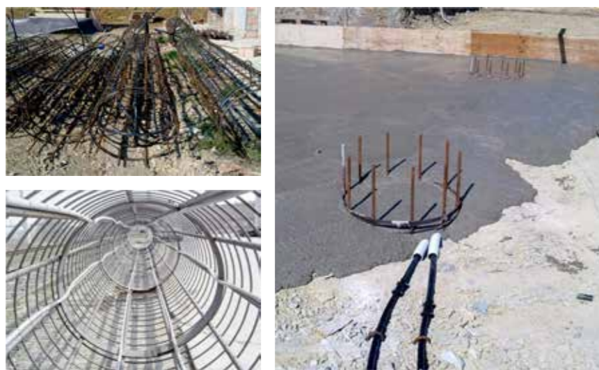
Foto 13. A sinistra, pali energetici su cui sono già stati montati i collettori; a destra, pali energetici messi in posa (foto Rehau).
