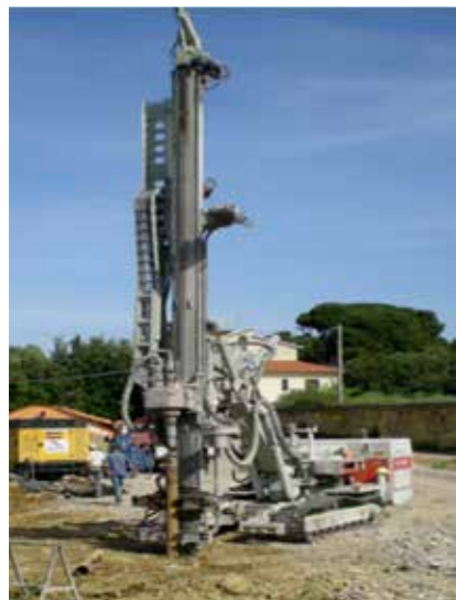
Foto 11. A sinistra, torre di perforazione per lo scavo del pozzo geotermico; a destra, macchinario che srotola la sonda all'interno del pozzo (foto Studio Ecogeo).
