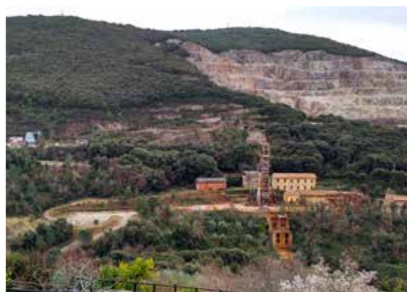
Foto 5. La miniera di Gavorrano con il Pozzo Roma e alcuni resti degli impianti esterni. A sinistra la sede del Parco delle Colline Metallifere; a destra, in alto, il Teatro delle Rocce.
