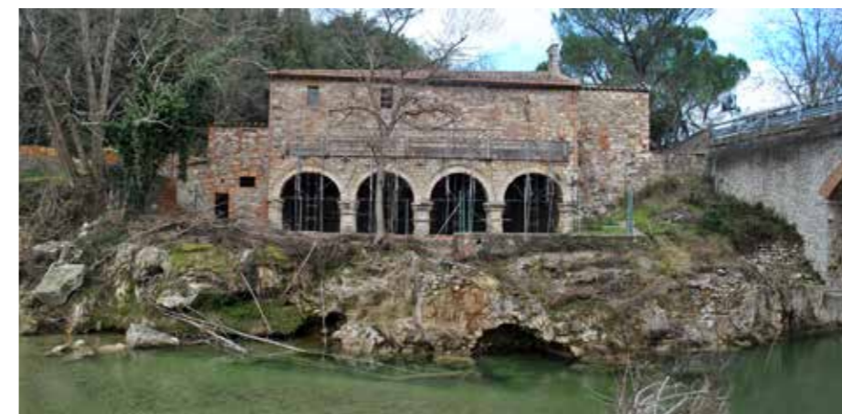
Bagni di Petriolo, edificio delle terme antiche e chiesetta (foto di A. Paoella).
