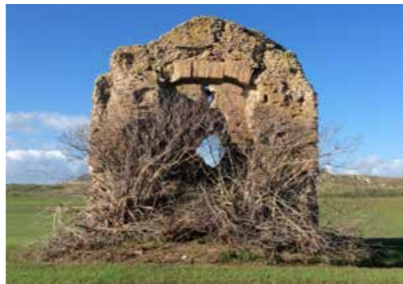
Foto 2. La “Lettighetta”, edificio a pianta quadrata posto a lato della antica via Cassia nei pressi delle terme del “Bagnaccio” (VT). Resti romani di un tempio, di una tomba o di antiche terme?
