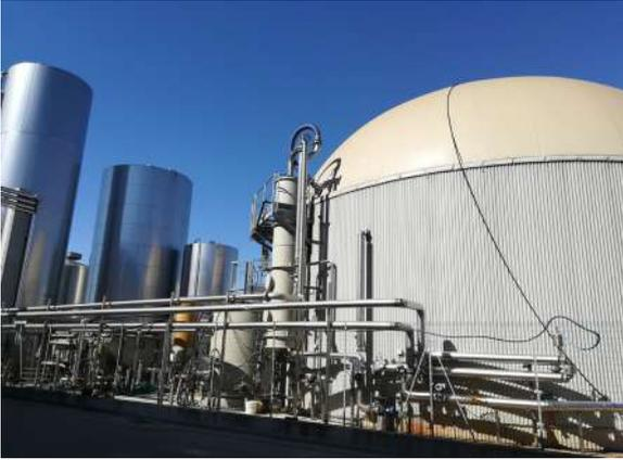
Proceso mixto completo con recirculación de biomasa anaeróbica que permite un aumento de la concentración de biomasa y una reducción del volumen del digester. Adecuado para efluentes con DQO > 40 000 mg/l.
