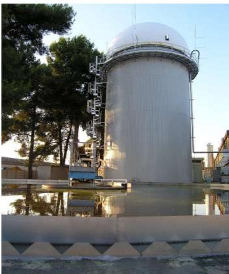
Digester en el que crece un lodo anaeróbico "granular" particular. Usados directamente en efluentes, siempre que tengan DQO soluble (azúcares, almidones, etc.), con DQO > 2000 mg/l.
