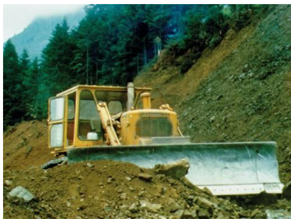
Διάνοιξη δασικού δρόμου
