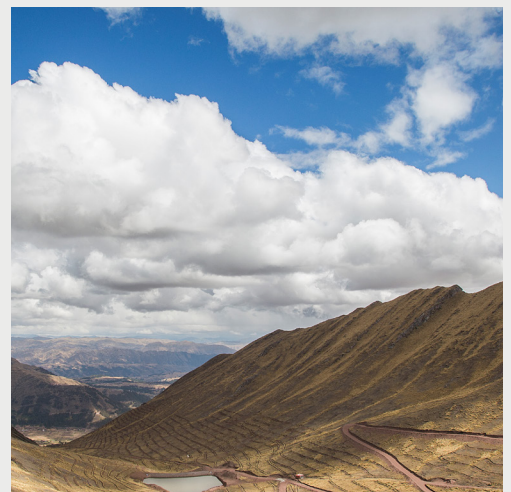
Figura 1. Zanjas de infiltración en la microcuenca Can Can, que abastece a la Laguna Piuray, Cusco, Perú.
