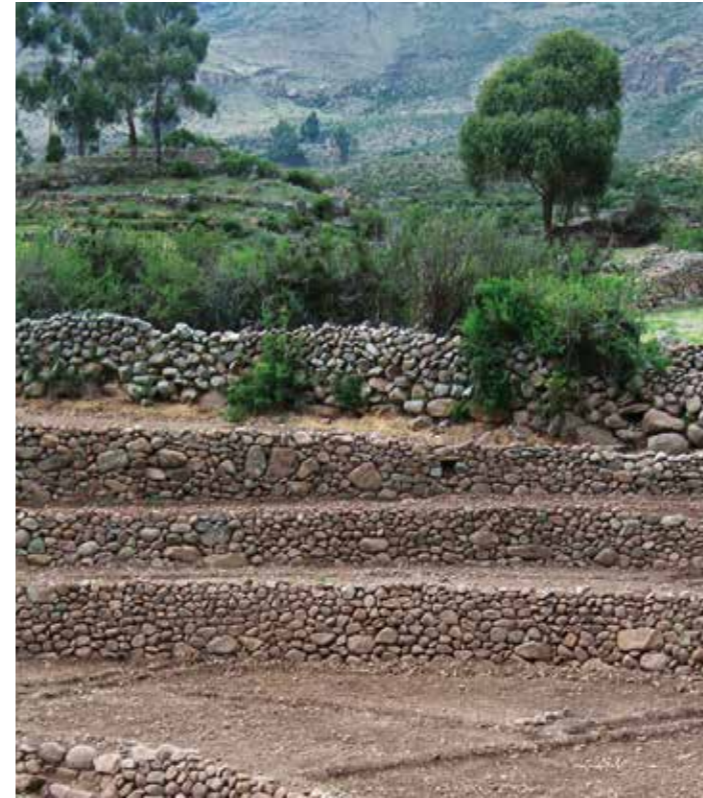
Rehabilitación de andenes (Andamarca, Ayacucho) | Foto: Asociación Andina Cusichaca
