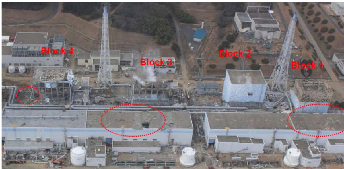
Zerstörte Anlage Fukushima Daiichi
