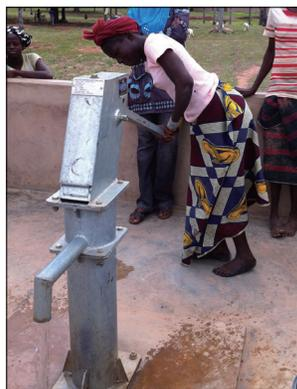
Collecte de l'eau d'un forage avec une pompe à main
