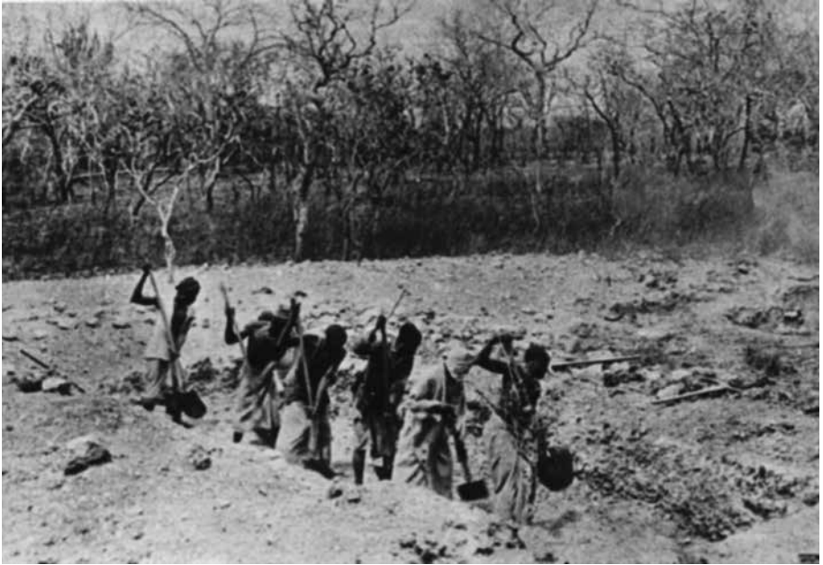
Desmalezamiento del terreno.
