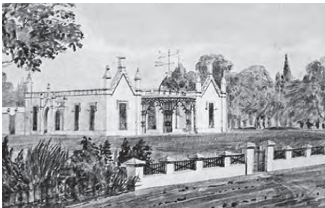
Quinta en el pueblo de Flores, alrededor de 1840-50, donde se aprecian algunas formas vegetales nuevas. Un cerco está construido con pilares de mampostería y lienzos de madera, al costado, dos tipos de cerca, uno con apoyo vegetal y otro de madera al fondo. (MHN).
