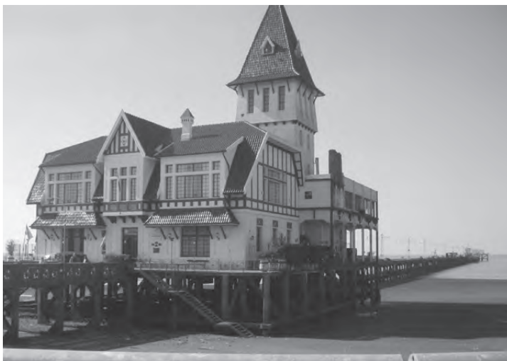
Figura 12. Imágen del muelle construido en la franja costera de la zona metropolitana. Club de pescadores de Buenos Aires, fotografía de C. Baigún.
