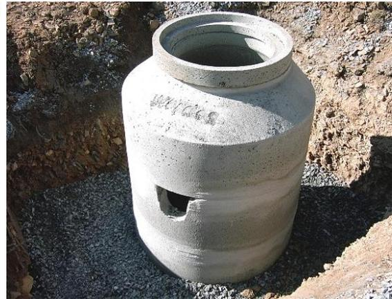
Bild 10: Schachtversickerung
