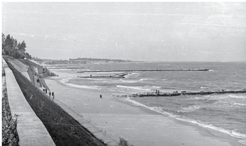
Рис. 53. Фигурные берегозащитные «длинные» буны на западном берегу Черного моря, к югу от Констанцы, пляжи Эйфория-Юг, Румыния, надежно защищают берега от гидрогенного разрушения (фото Ю. Д. Шуйского).
