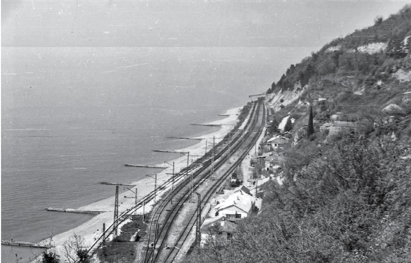
Рис. 52. Защита береговой железной дороги пляжеобразующими бетонными бунами (вид на северо-запад) на Кавказском побережье Черного моря. Район в Республике Грузия, недалеко от города Гагры (фото Ю. Д. Шуйского).
