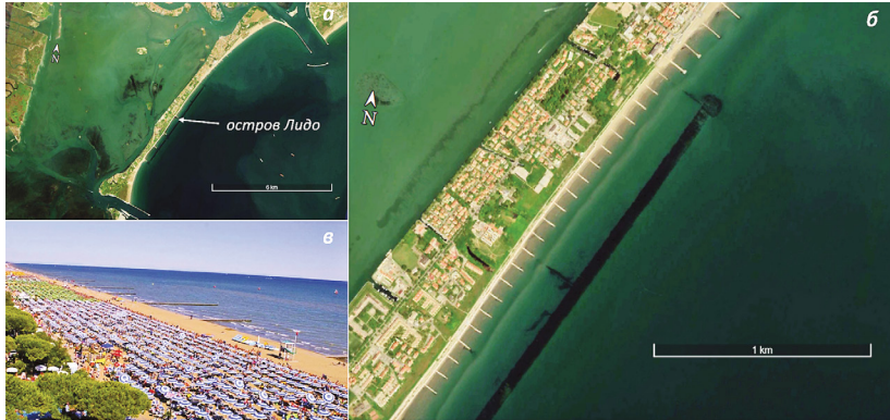
Рис. 11. Берегозащитный комплекс острова Лидо, в районе Венеции (Италия), северо-западный берег Адриатического моря: а – внешний вид острова Лидо; б – «наносоудерживающие» буны вдоль фронтального берега острова; в – внешний вид песчано-гравийного пляжа (разработано в ресурсе Google Earth ).
