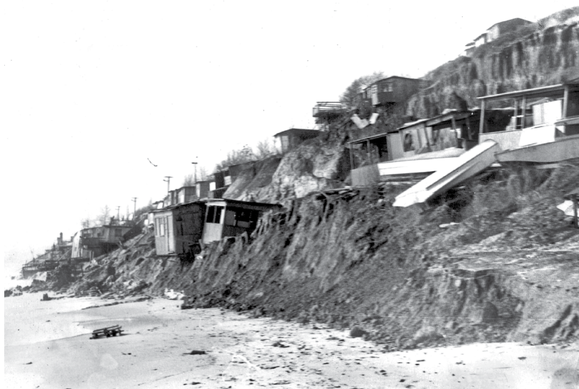
Рис. 58. Экологи рекомендовали «безопасный» участок абразионно-оползневого берега Черного моря для постройки рыбацко-дачного поселка. Через 9 лет поселок оказался разрушенным (фото А. Б. Муркалова).
