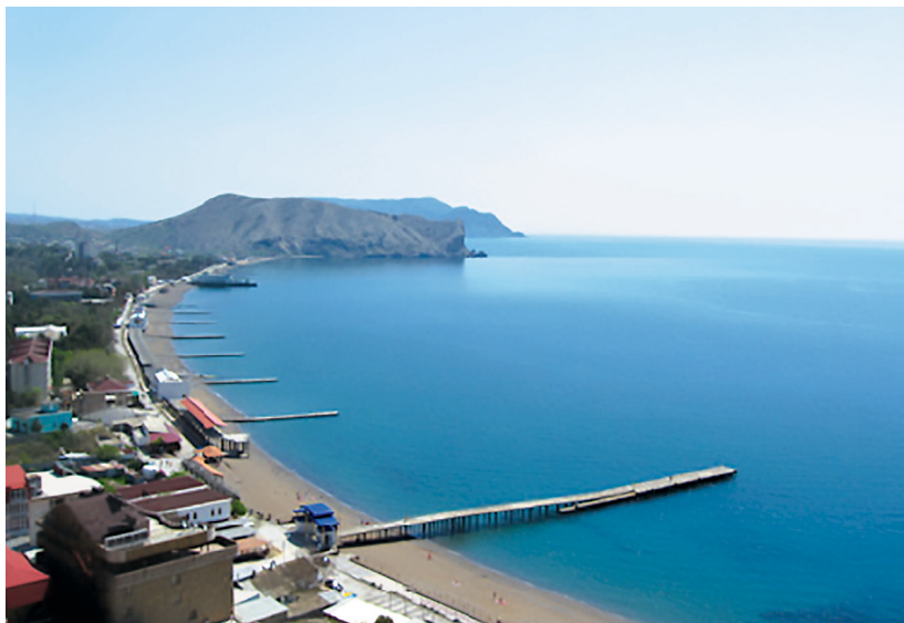
Рис. 1. Пример удержания гравийно-галечных наносов на пляже с помощью морских бун в пределах Судакской бухты.
