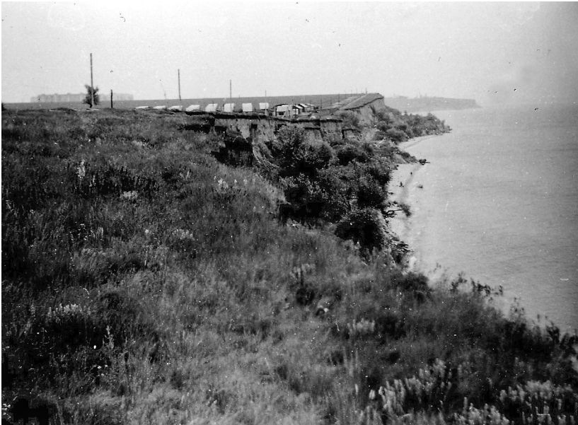
Рис. 60. Неудачный выбор расположения летней базы отдыха на абразионном берегу в районе гор. Южный. Многолетняя растительность на оползневых блоках горной породы (оползневых террасах) уходит в море, хотя предназначалась для «защиты» от абразии. В естественном состоянии скорость абразии клифа составляла 1,7 \text{ м/год} (фото Ю. Д. Шуйского).
