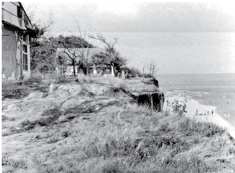
Рис. 37. Высокая скорость абразии обвального глинистого клифа (среднее 1,93 \text{ м/год} в течение 1952-2021 гг.) неукоснительно привела к разрушению части территории прибрежного поселка Лебедевка на северо-западном берегу Черного моря (фото Ю. Д. Шуйского).
