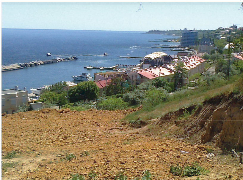
Рис. 88. Высокий абразионно-оползневой берег Черного моря, укрепленный траверсами, волноломами, бунами, каменной наброской. Слева на ближнем плане – гавань для маломерных плавсредств, вдали – мыс Большой Фонтан, берег на территории Одессы (фото Ю. Д. Шуйского).
