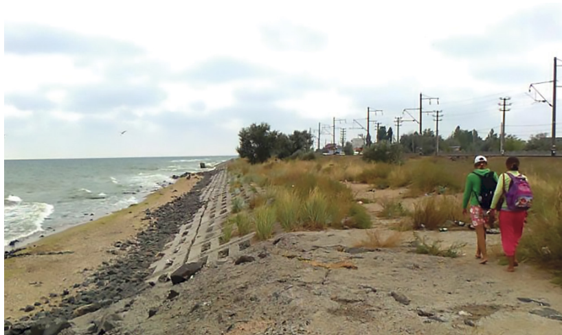
Рис. 54. С 1987 г. искусственная терраса защищает железную дорогу от разрушения на пересыпи Днестровского лимана, северо-западный берег Черного моря (фото Ю. Д. Шуйского).
