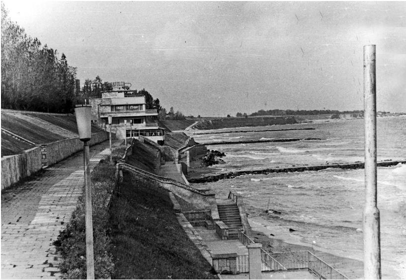
Рис. 67. Редкие буны не могут удержать песчано-алевритовый пляж, сложенный фракцией 0,05-0,25 мм, на западном берегу Черного моря в районе севернее Мангалии, Румыния (фото Ю. Д. Шуйского).
