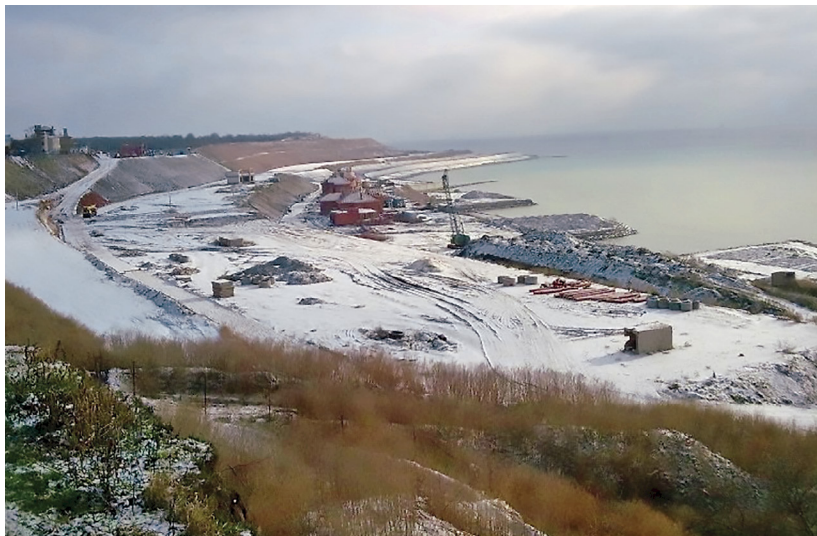
Рис. 43. Создание искусственной террасы в Одесском заливе Черного моря лишило основной части питания наносами пляжей на пересыпках Куяльницкого и Хаджибейского лиманов. Необоснованный расчет на естественное заполнение наносами вогнутостей на фронтальной кромке террасы не оправдался.
