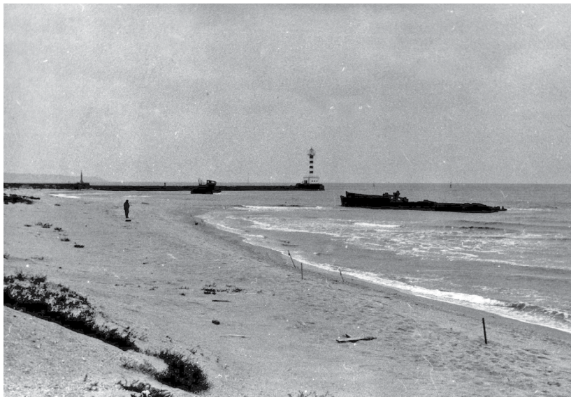
Рис. 51. Искусственный пляж сохраняется в волновой тени от внешнего южного мола порта Ильичевск и под защитой «искусственного волнолома» (затопленная баржа) в 1990 г. (фото Д. Я. Бергмана).
