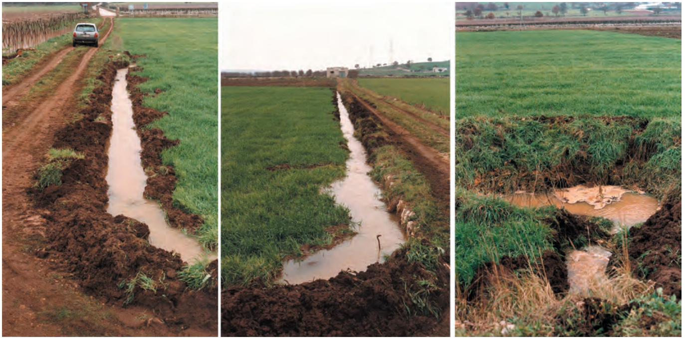
Figura 2 – Immagini del canale provvisorio scavato nel 1996 (a sinistra e al centro) e deflusso continuo delle acque nell’originale Inghiottitoio della Masseria Rotolo (a destra).
