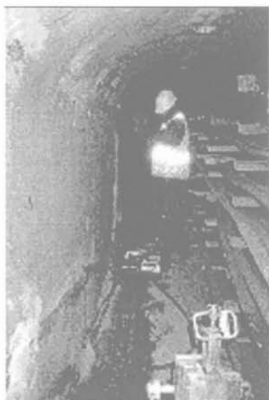
FIG. 7 Réalisation de sondages dans une galerie technique. Test realisation in a technical buried structure.
