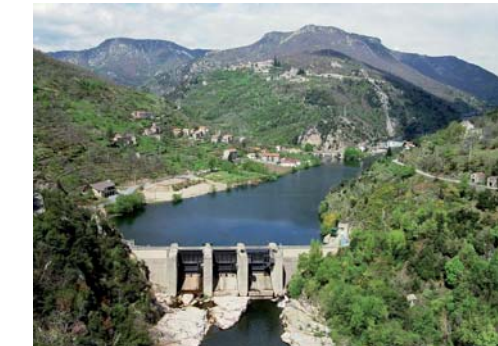
Barrage de Pied-de Borne sur le Chassezac
