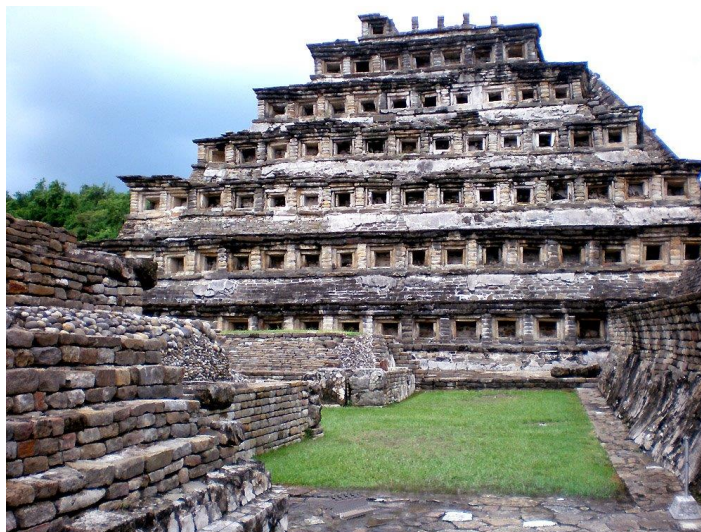
Figura 32. Deterioro de la zona arqueológica El Tajín a causa de la lluvia ácida.
