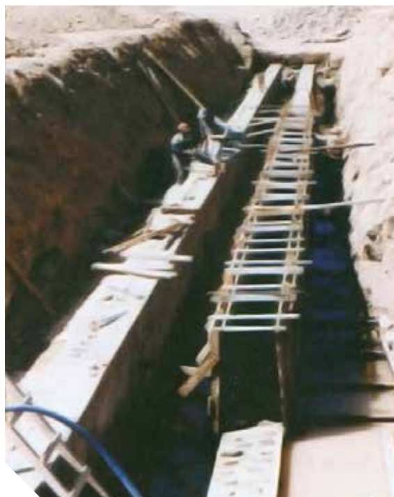
▲ Galería Río Seco (Tarata) Etapa de la construcción
