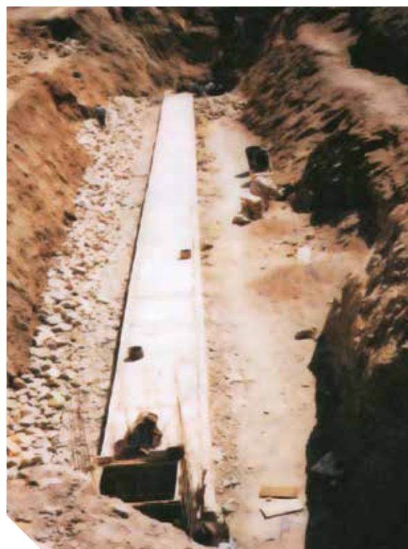
▲ Galería Loro Mayu; proceso de construcción
