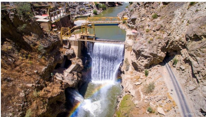
Figura 36: Obras Civiles a vista de Drone, Cañón del Pato, Huaraz (Por: Walter Lozano, grupo DJI Drones Perú)
