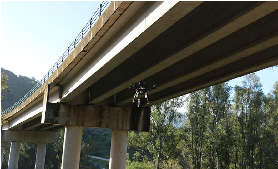
Figura 34: Uso de Drone en evaluación de estructura de puente
