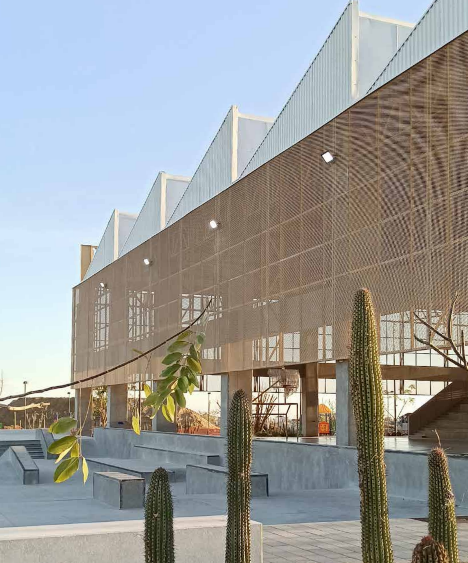
Fotografía 1. Construcción de Centro Deportivo, Los Cabos
