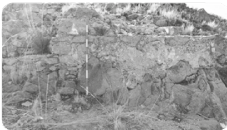
Fig. 31. Punto de vigilancia anexo al Torreón 1.
