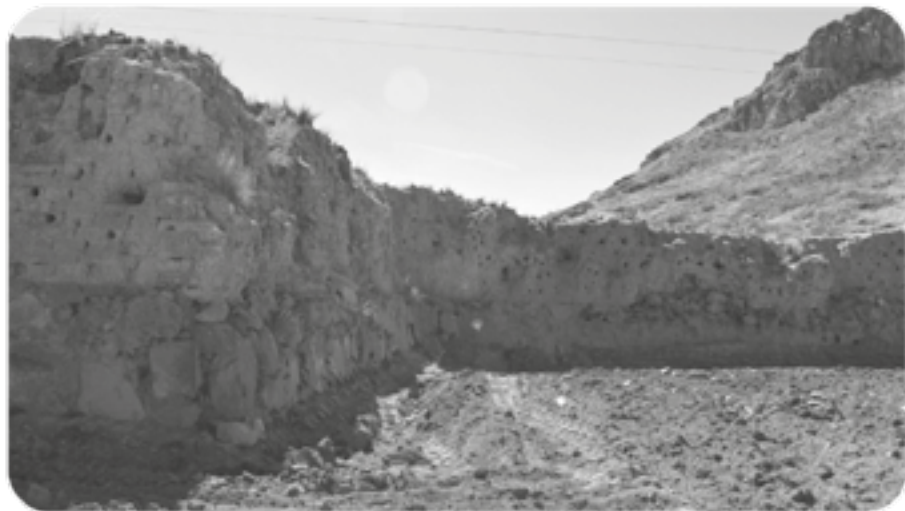
Fig. 25. Vista frontal de la Muralla B.
