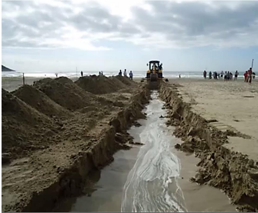
Figura 7. Abertura artificial da barra da lagoa Ibiraquera, região integrante da APABF.
