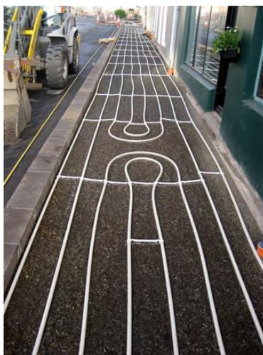
Figura 49 Riscaldamento geotermico dei marciapiedi per eliminare il ghiaccio (fonte: <https://wowair.us/magazine/energy-in-iceland/>)
