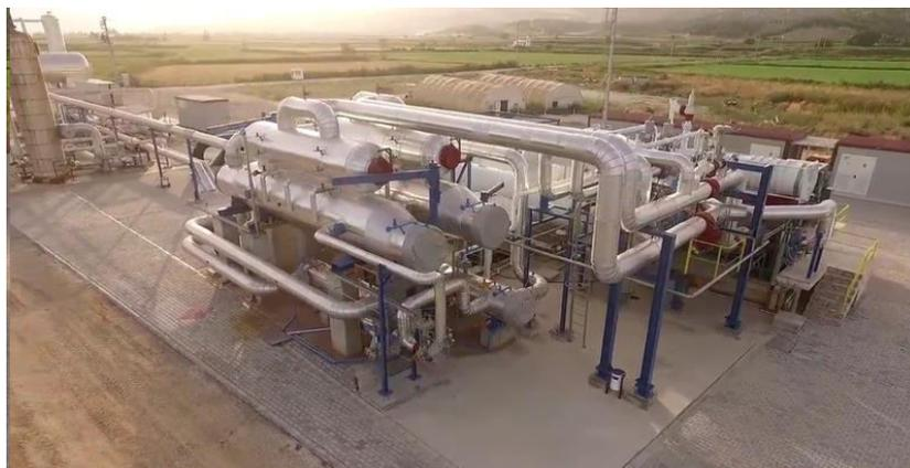
Figura 38. Impianto binario geotermico da 3,5 MW, installato a Denizli Tosunlar, Turchia (fonte: Exergy s.p.a.)
