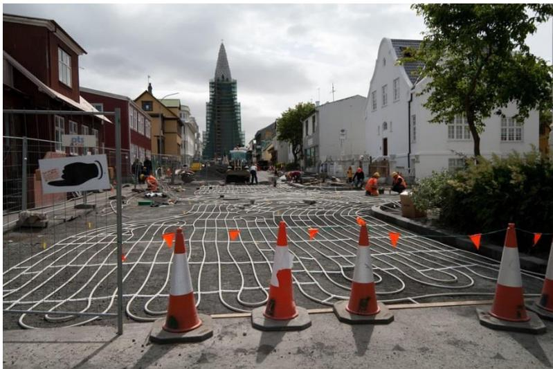
Figura 48 Riscaldamento geotermico delle strade per eliminare il ghiaccio (fonte: <http://www.thinkgeoenergy.com>)
