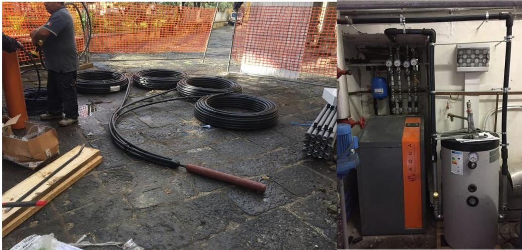
*Figura 46 Pompa di calore geotermica con sonde verticali installate presso il sito dimostratore di Largo San Marcellino-Napoli (fonte:Craveb)*
