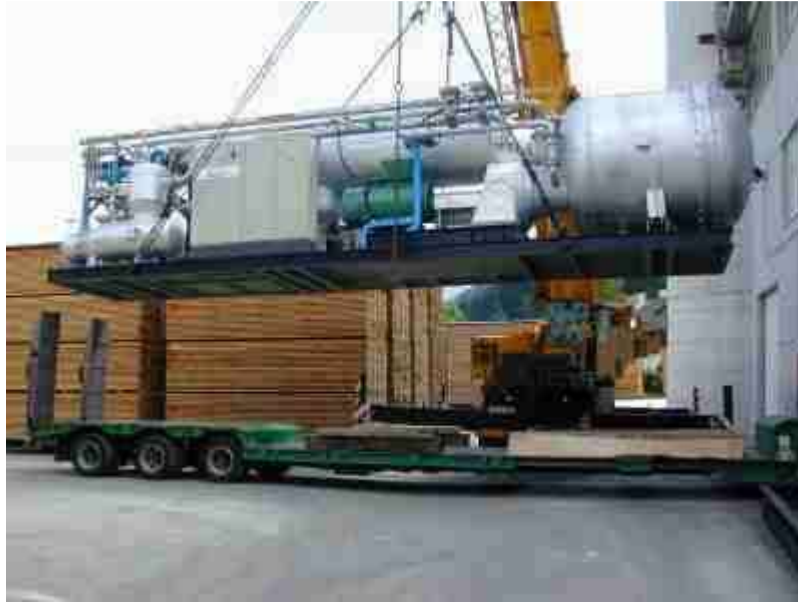
Figura 28 Impianto ORC da 400 kWe (fonte: http://www.ieabcc.nl/ )
