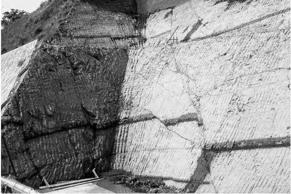
第7.2図 島尻層群に発達する共役断層 このような共役断層が随所に存在する。那覇市字栄原団地にて1987年撮影。
