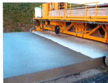
Bild 3: Oberflächentextur mittels Jutetuch bei Betondecken
