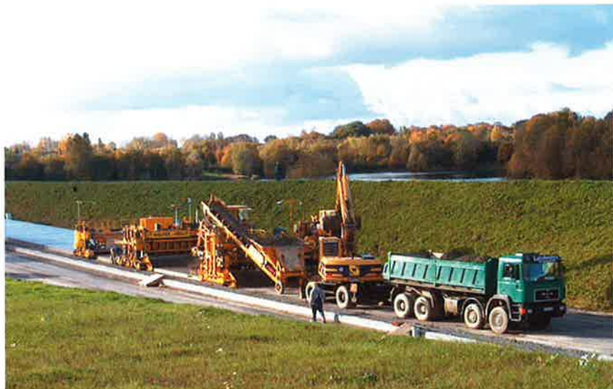
Betondeckenbau mit qualifiziertem Personal und leistungsfähigem Gerät
