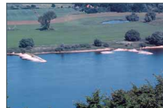
Depósitos de sedimentos en espigones
