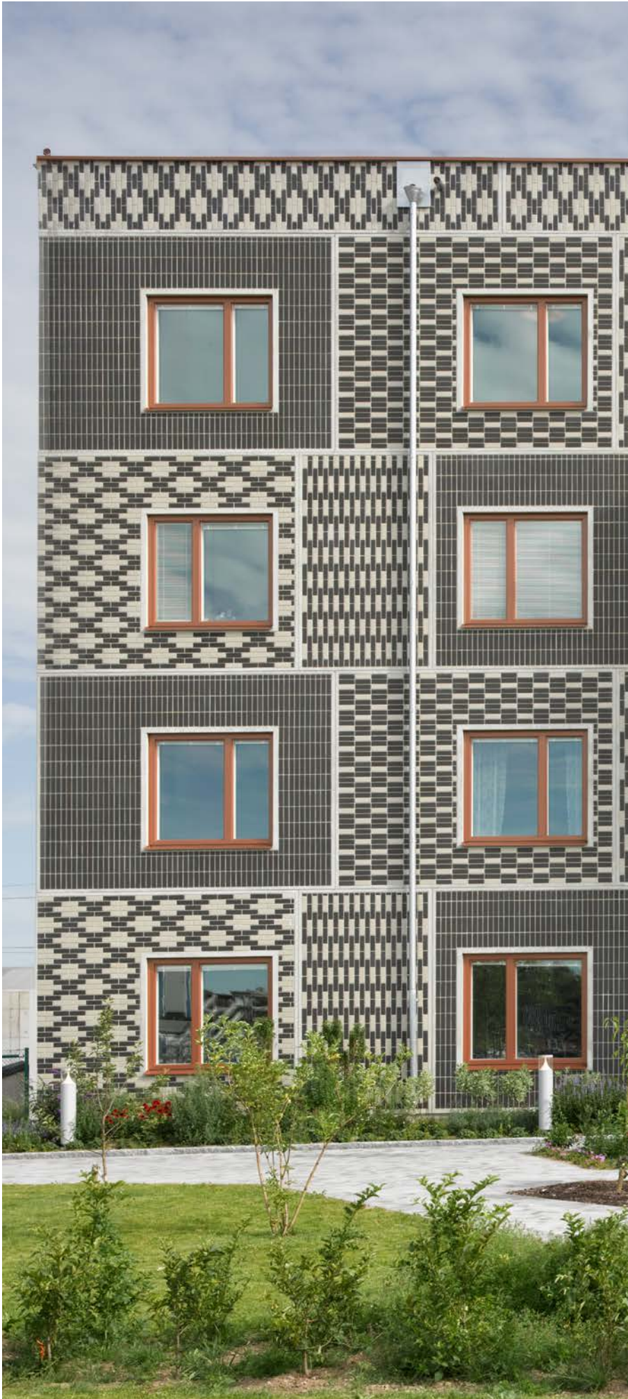
Humana Äldreomsorg, Växjö, SE Planung: Kjellander Sjöberg, Stockholm, SE Sto-Kompetenzen: StoBrick Glatt Uni 100, Format: 240x71 mm; StoBrick, individuelle Oberfläche, Format: 240x71 mm Foto: Max Plunger Photography, Nacka, SE
