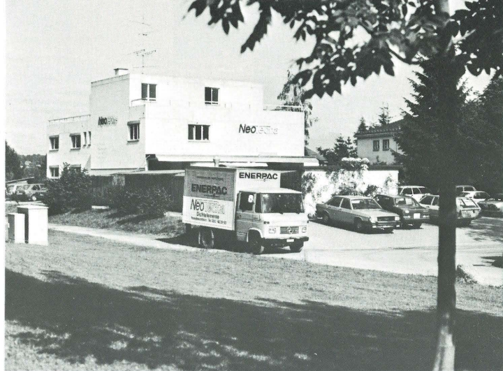
Das 1973 bezogene Gebäude in der Holgass
