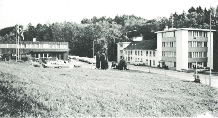
Alt- und Neubau der Schleiffer-Gruppe im Garstlig
