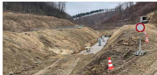
Der Baufortschritt ist schon deutlich zu erkennen.
