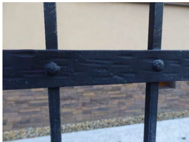
Obr. 19 Spojovací nýty na konstrukci plotu (foto spoluautor článku)
