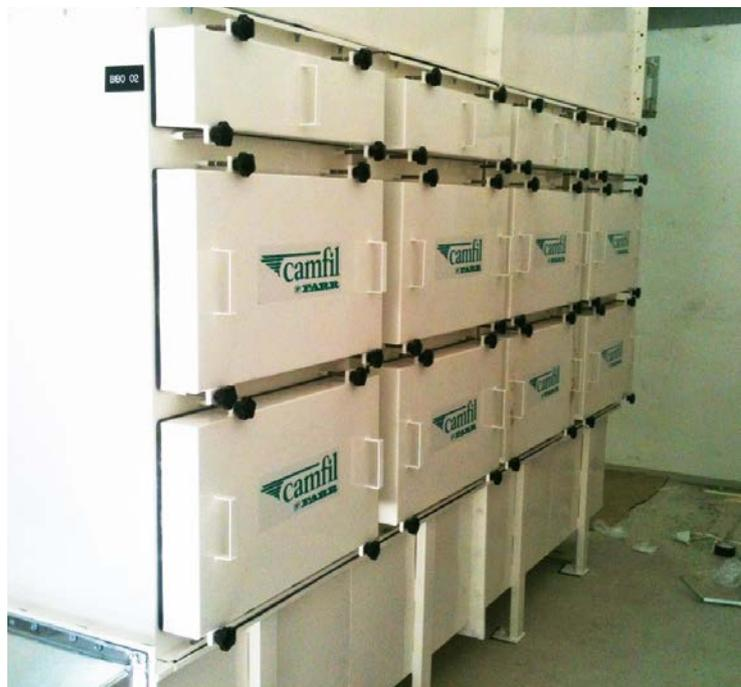
**8** Con las nuevas celdas calientes se instaló un sofisticado sistema de ventilación con prefiltrado, filtros de alta eficiencia (HEPA) y filtros de carbón activo, diseñado con un sistema de doble filtro para aumentar la seguridad.
