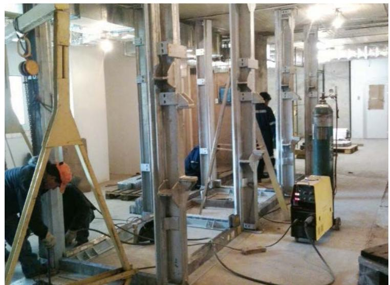
3 El edificio se demolió parcialmente a fin de construir nuevas paredes y losas de refuerzo que pudiesen soportar el peso de las celdas calientes nuevas. Se contrató una empresa especializada para construir los pilares de hormigón. Esta fase de la construcción incluyó también el montaje de la estructura de sustentación de los ladrillos de plomo.
