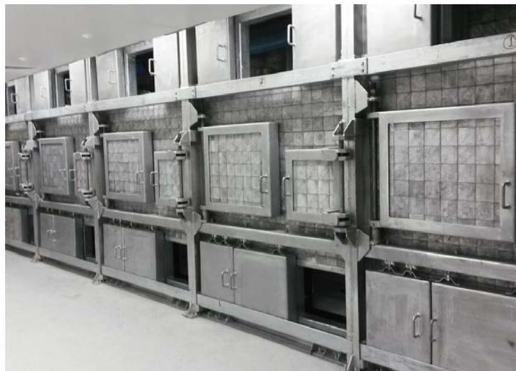
**6** Se instalaron paredes y puertas de plomo para garantizar la seguridad de la “zona caliente” de la instalación, el área donde están los materiales radiactivos. La “zona caliente” también es el área en la que se ponen las materias primas radiactivas y de la que se sacan, tras el procesamiento en celdas calientes, los productos terminados (es decir, los radiofármacos).
