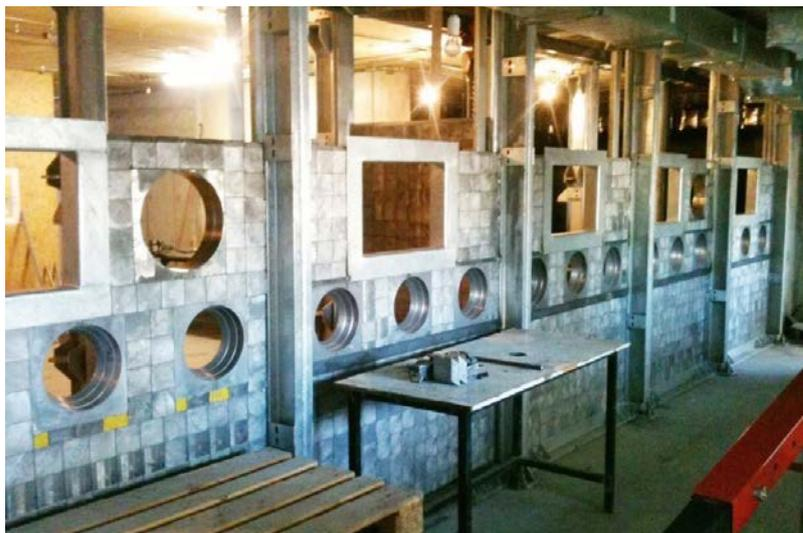
**5** Las celdas calientes para producir radiofármacos de tecnecio 99m y yodo 131 se construyeron con ventanas de vidrio al plomo y marcos de enclavamiento para montar los telemanipuladores. El OIEA suministró las ventanas de vidrio al plomo y los telemanipuladores, que fueron instalados por técnicos que trabajaron en colaboración con personal de la Comisión Chilena de Energía Nuclear (CCHEN).
