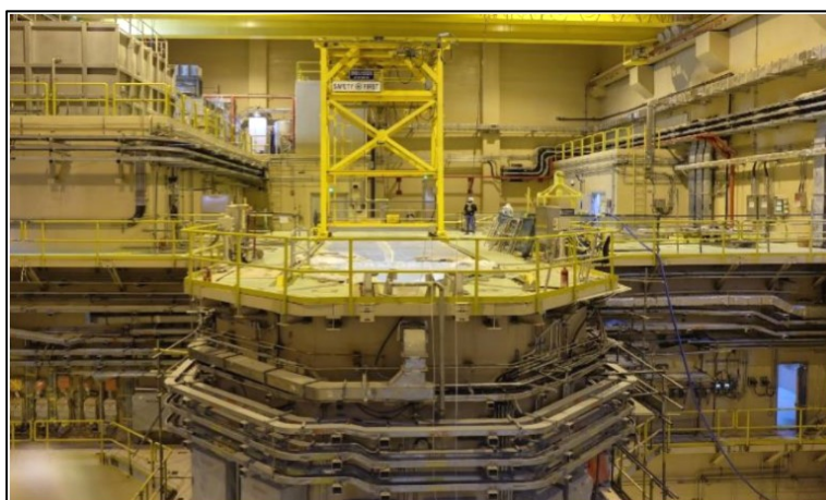
المشروع JOR/1/005: مفاعل البحوث والتدريب الأردني قيد التشييد في إربد بالأردن.
