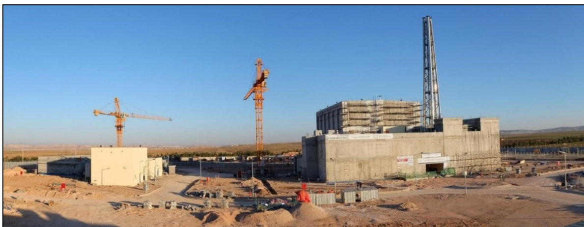
موقع محطة أردنية للقوى النووية قيد التشييد.
