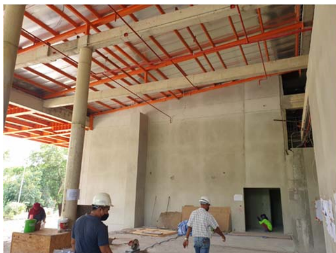
أعمال التشييد الجارية في مبنى مجمع السيكلوترون (الصورة من: الدكتور كانكوبورن بونسيريتشاي، معهد تايلاند للتكنولوجيا النووية)
