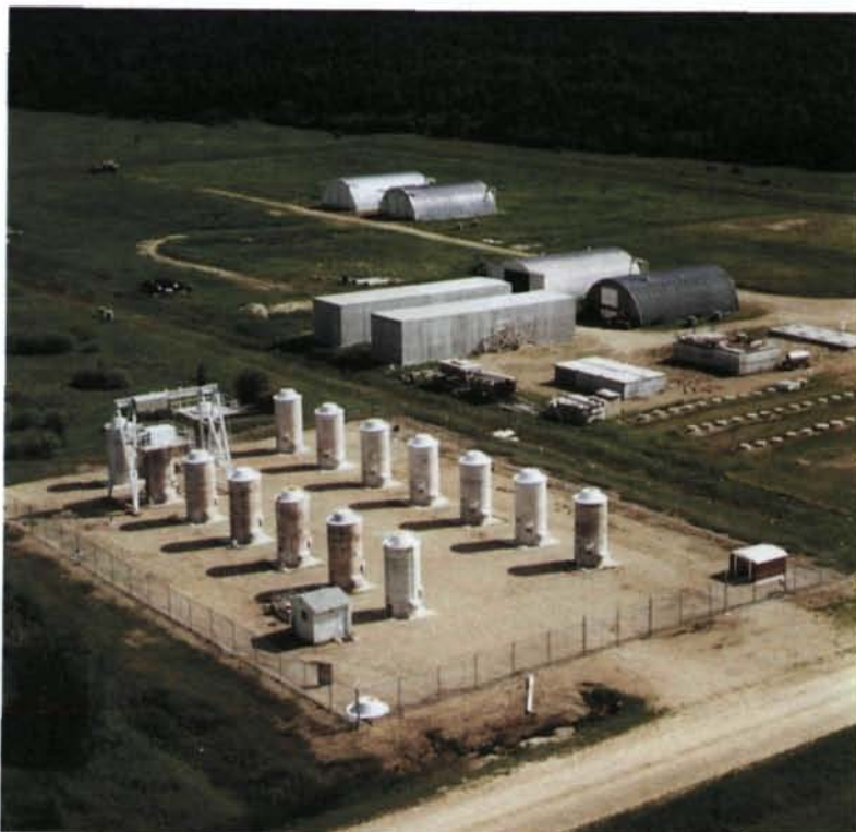
Vue aérienne d'une installation de stockage de conteneurs en béton au Canada. (Crédit: AECL)
