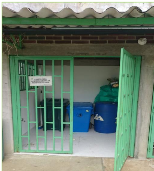
Imagen 5: Cuarto de Almacenamiento Temporal de Residuos Sede Centro zonal Saravena.
