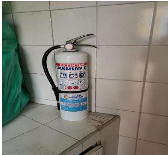
Residuos sin caneca y con extintor para equipos eléctricos
