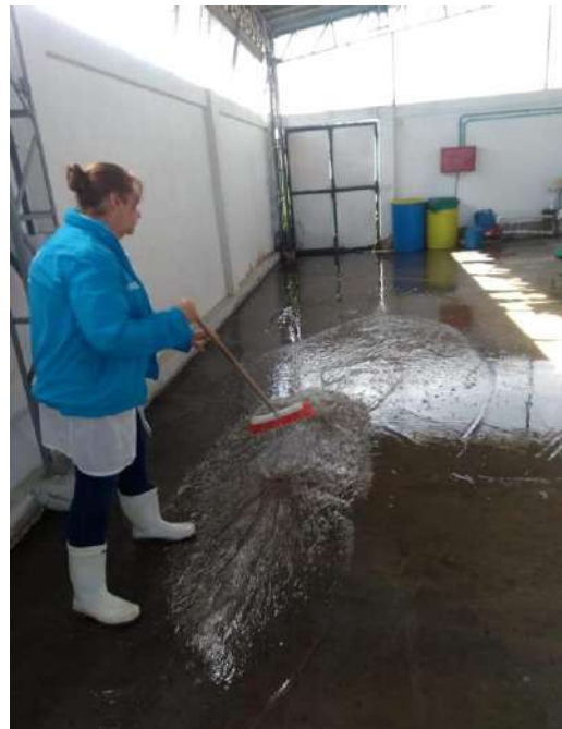
Inundaciones en la zona de lavandería
