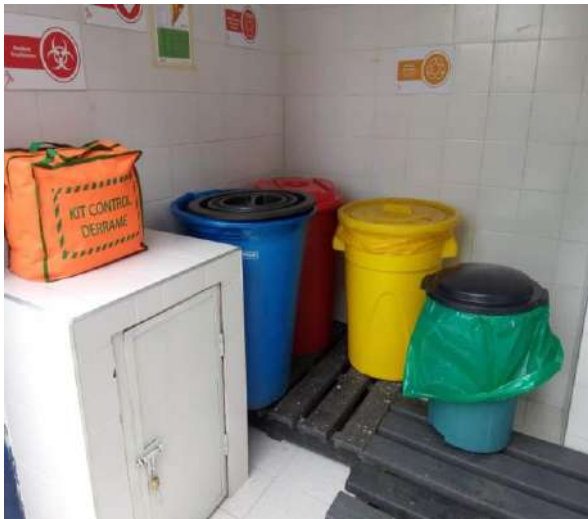
Canecas y señalización inadecuada
