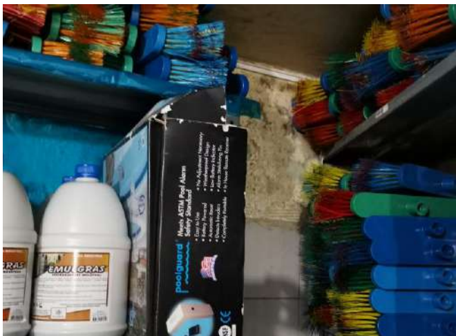
Humedad en la bodega de elementos de aseo
