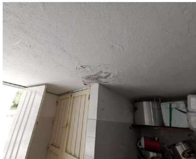
Humedad en el techo y paredes de la bodega de aseo, además de vidrios rotos al interior
