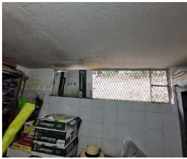
Humedad en el techo y paredes de la bodega de aseo, además de vidrios rotos al interior
