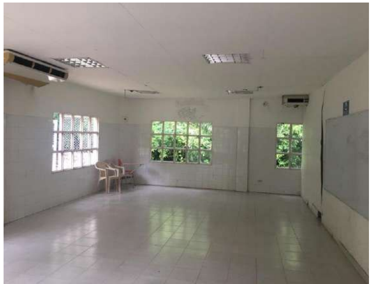
Paredes en mal estado y con inconvenientes de iluminación para el desarrollo de clases
