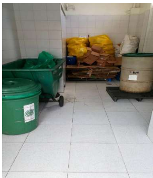
Canecas sin estibas, espacio inadecuado para reciclaje y sin señalización. No cuenta Con extintor, ni infraestructura adecuada.
