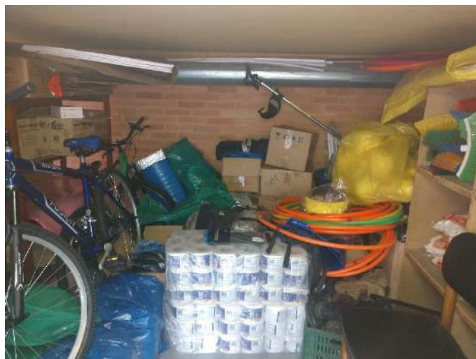
UPI Servitá: Disposición de elementos unos sobre otros dificultando acceso
