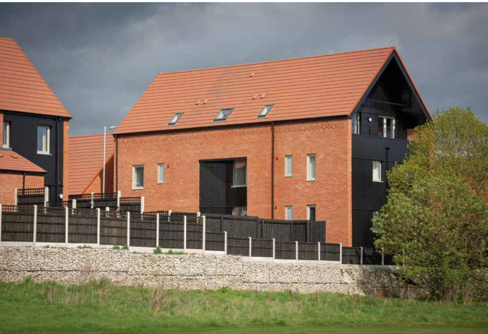
L'accesso dalla strada
