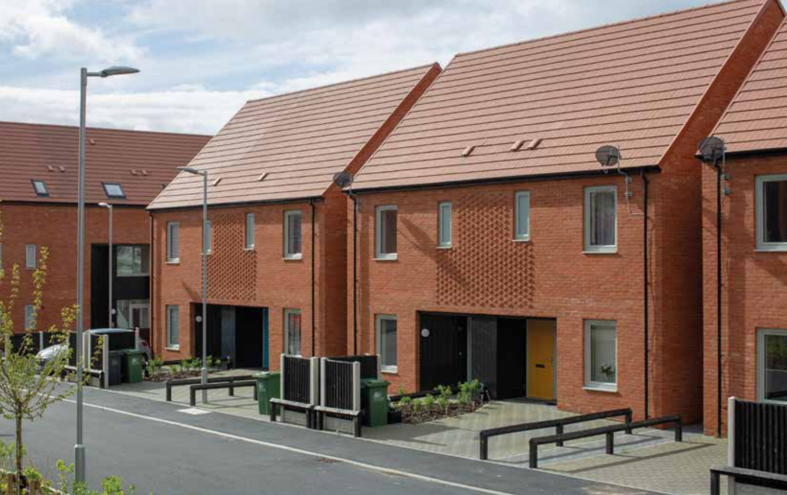
I tetti a falde e la tessitura in mattoni delle facciate
