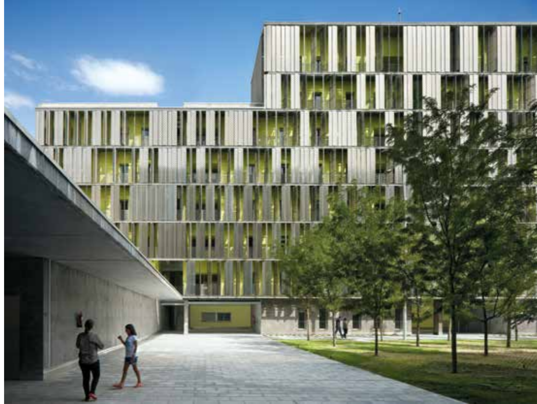
Il rivestimento grigio esterno con finestre regolari e quello verso la corte interna con brise-soleil verticali in alluminio traforato
