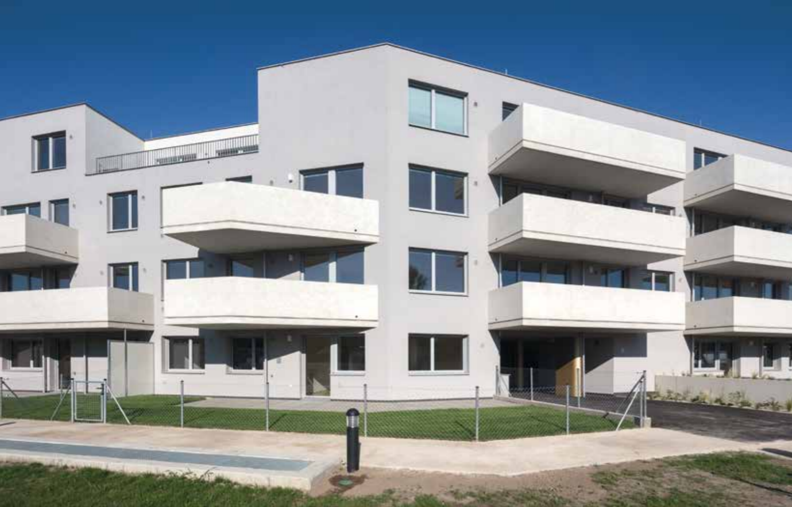
Il rivestimento grigio chiaro dei prospetti e i profondi balconi aggettanti in calcestruzzo bianco
