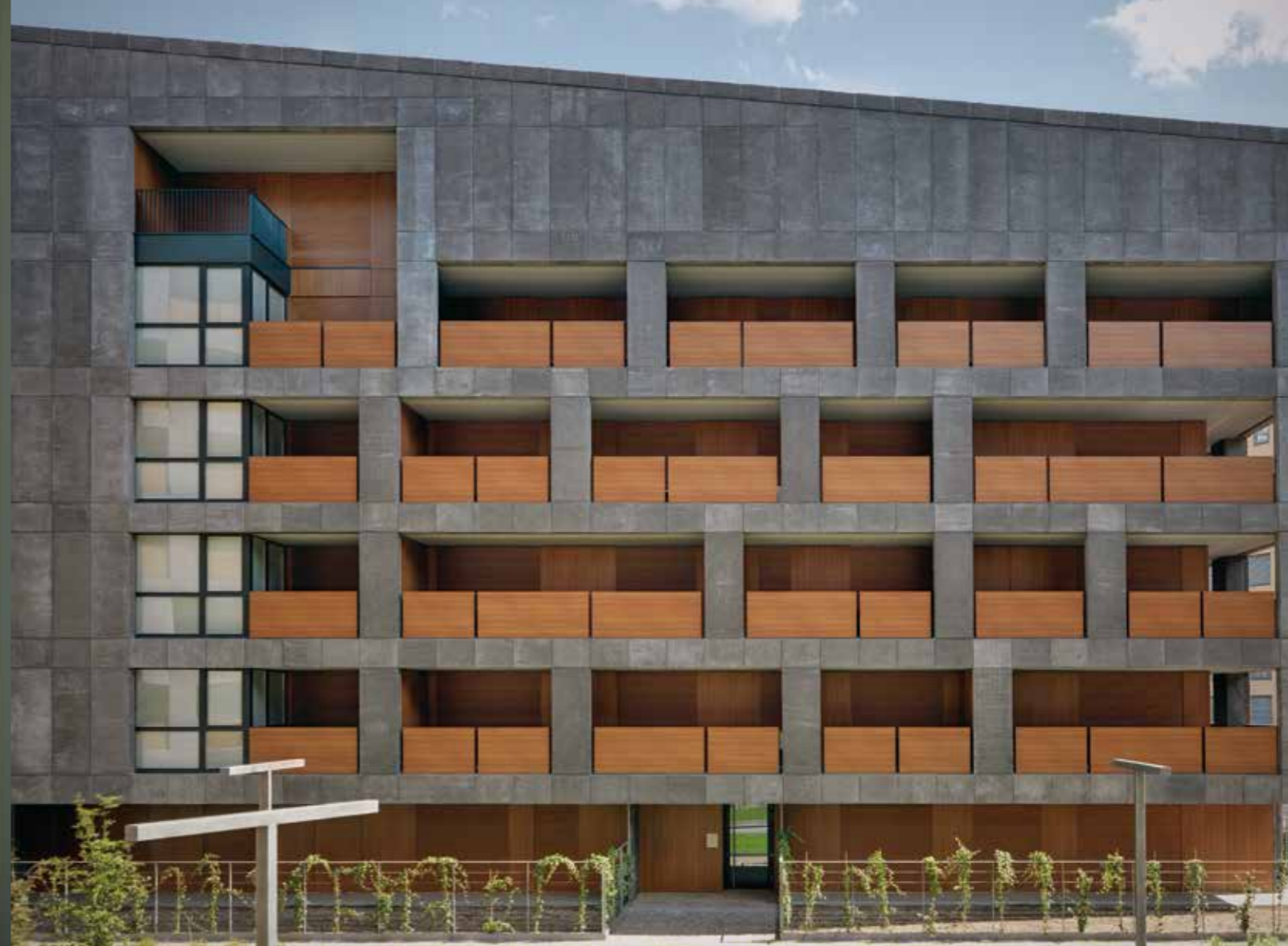
I prospetti rivestiti con pannelli di GRC e i parapetti in legno
