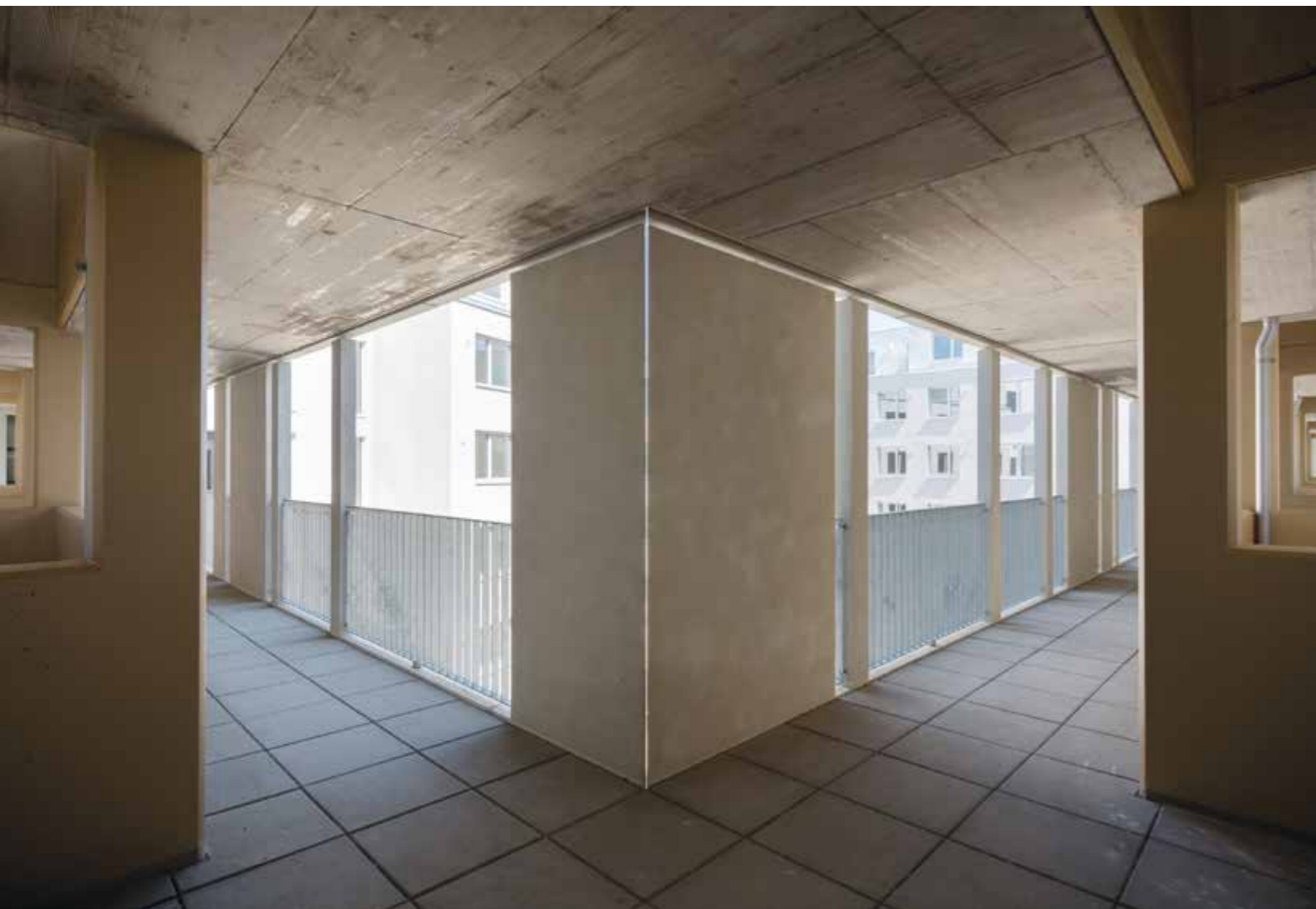
Le gallerie di collegamento ricavate nelle facciate per la circolazione interna
