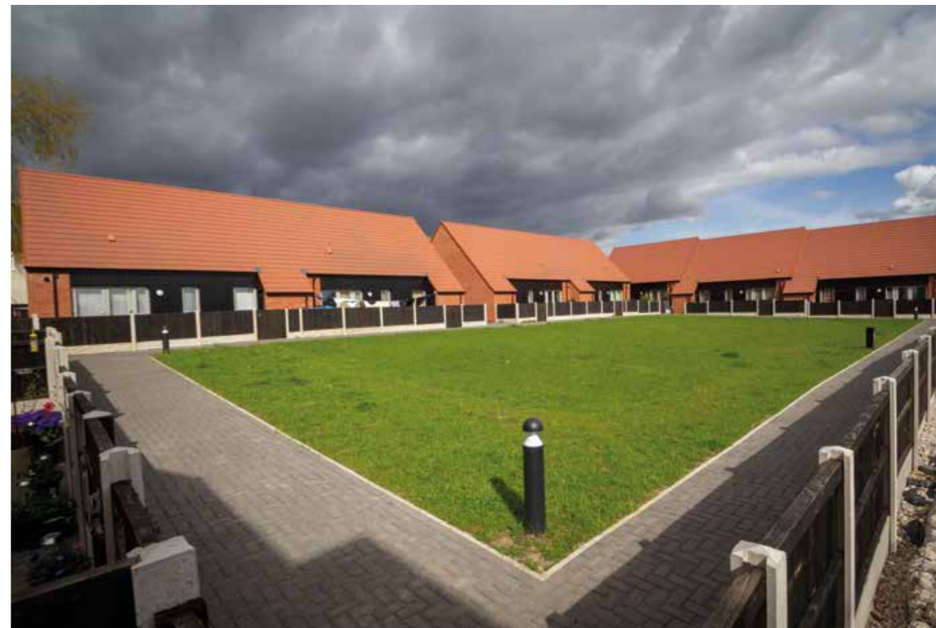
La corte centrale formata dalle case a schiera
