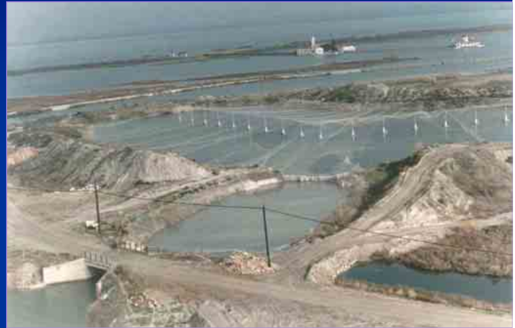
Μονάδα για αντιπαγετική προστασία και θέρμανση τεχνητών λιμνών στο Πόρτο Λάγος του Ν. Ξάνθης
