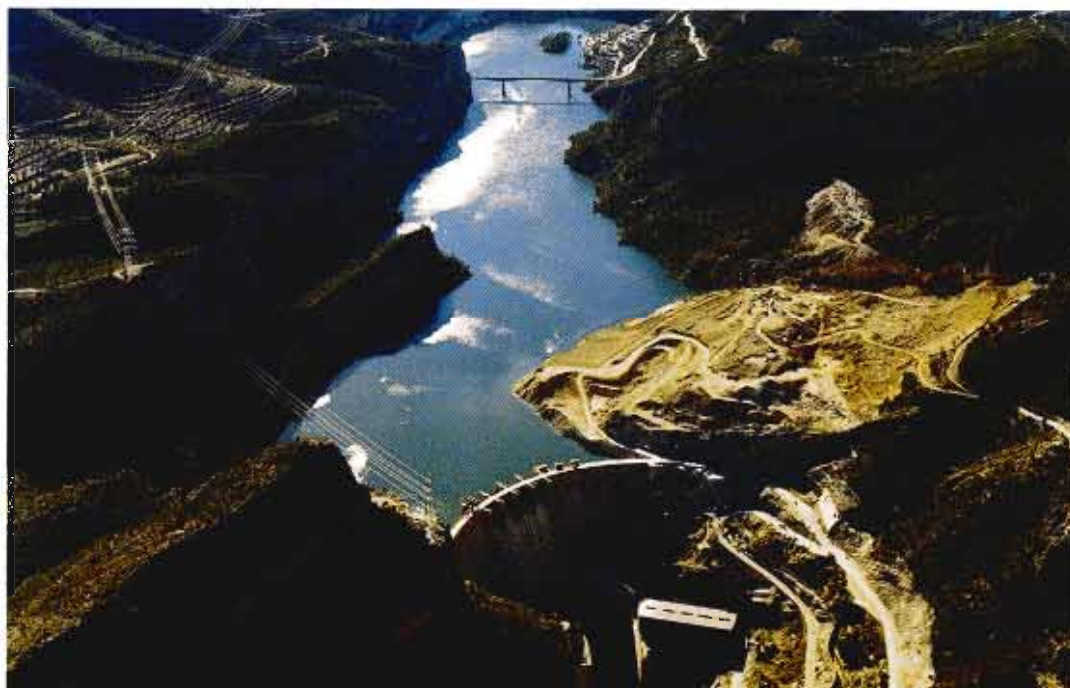
La producción de energía eléctrica es una buena forma de utilizar los recursos hídricos. Aprovechamiento hidroeléctrico del río Júcar en el complejo de Cortes de Pallás.
