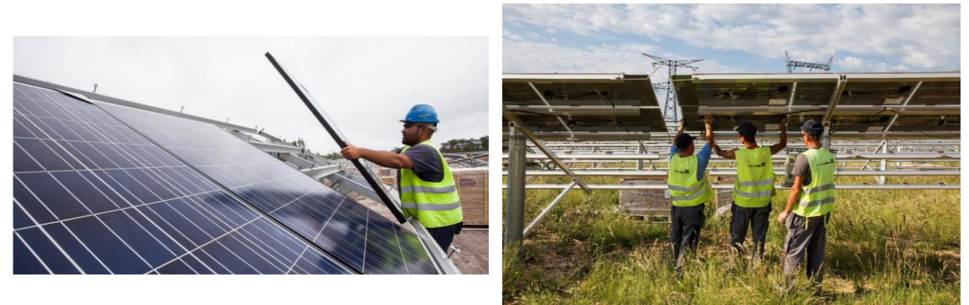
Figure 80 : Pose de modules
