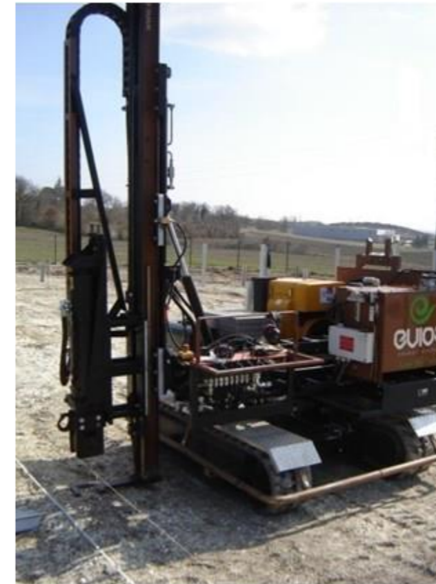
Figure 66 : Engin de battage de pieux
