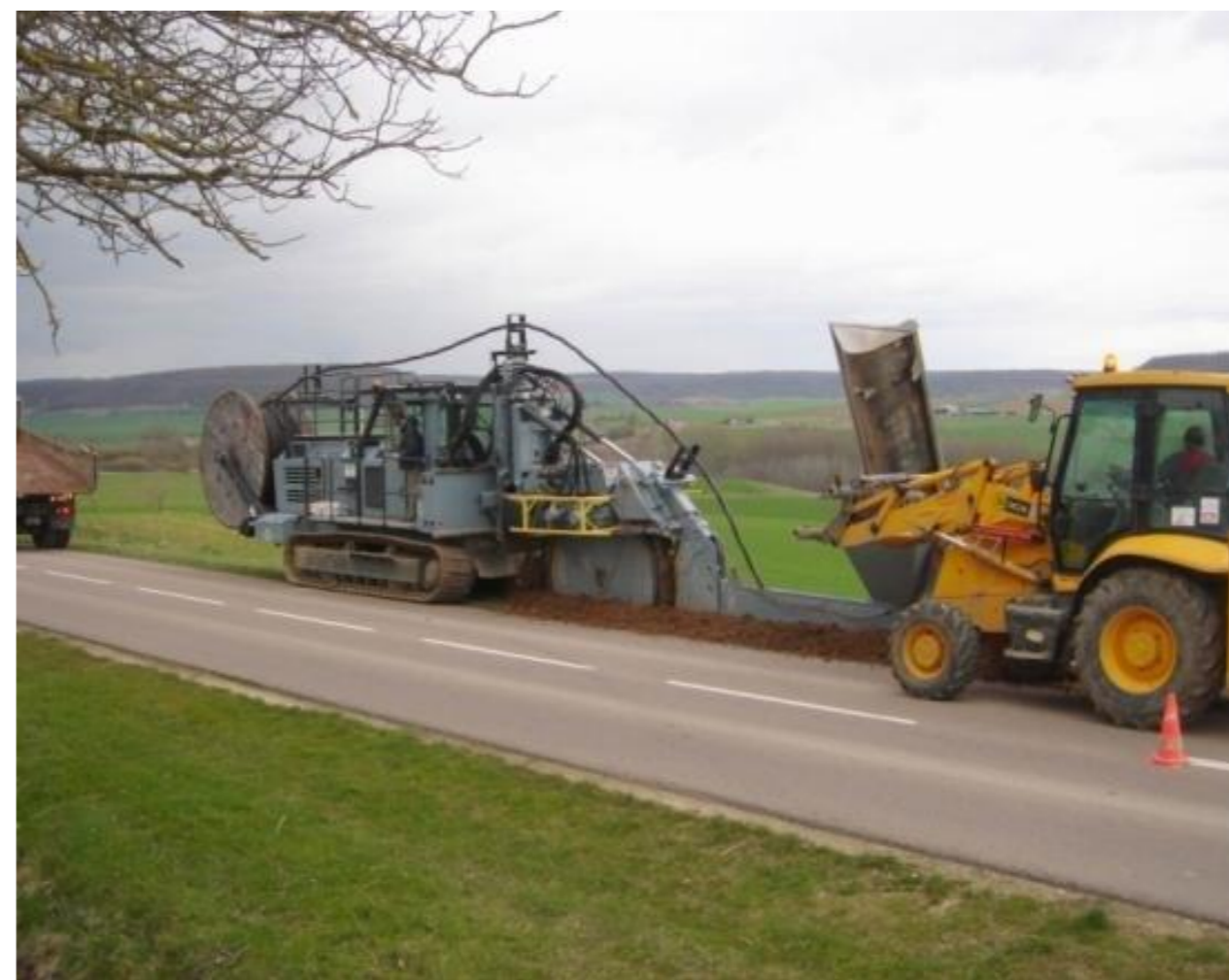
Figure 74 : Réalisation d'une tranchée
