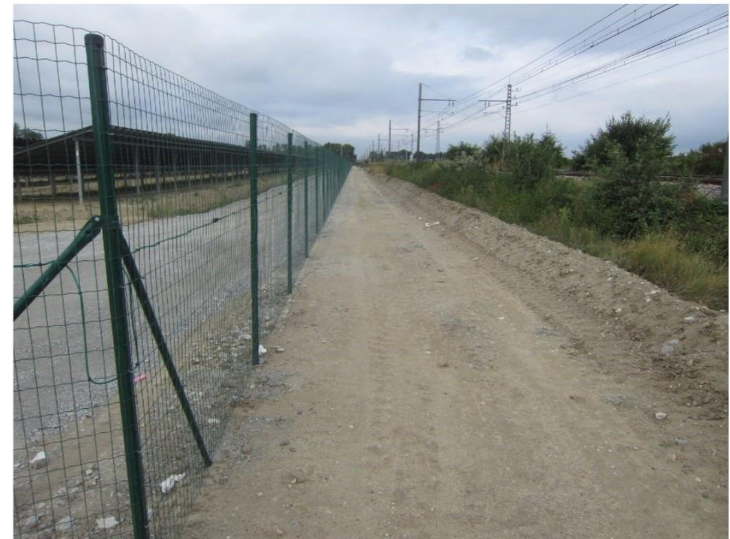
Figure 76 : Exemple de clôture et de pistes
