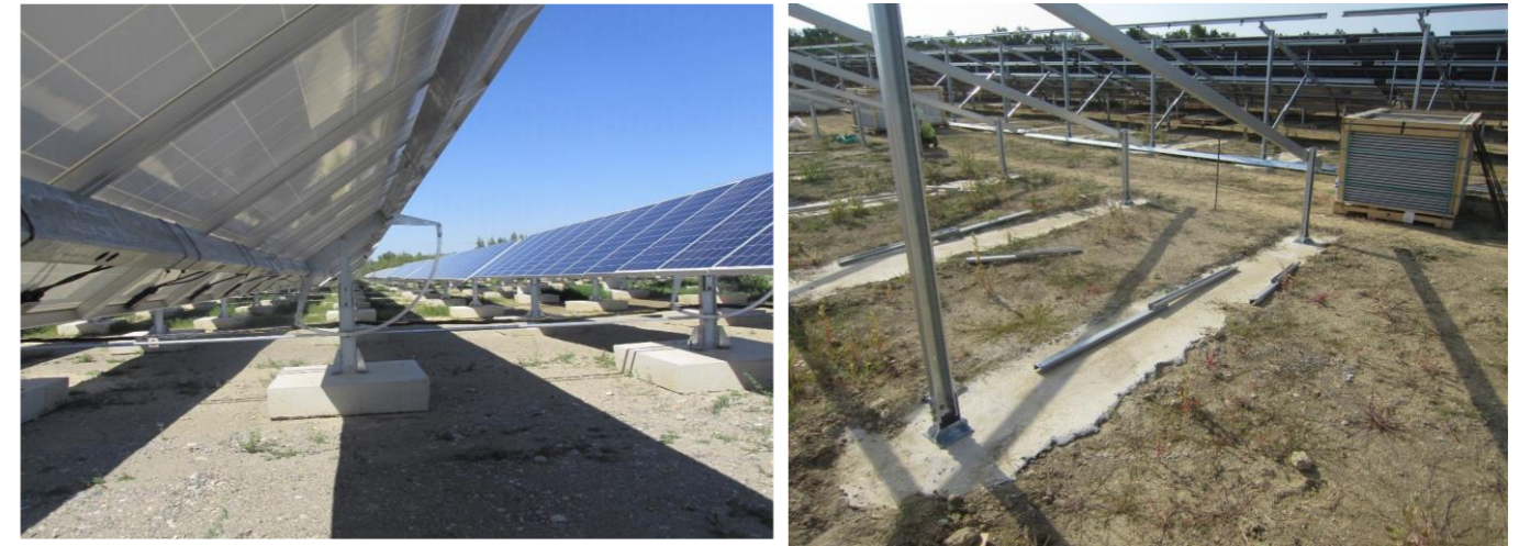
Figure 69 : Exemple de longrine béton (enterrée à gauche)
