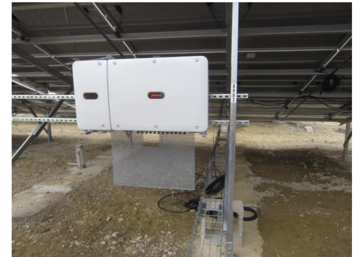
Figure 71 : Exemple d'onduleur décentralisé
