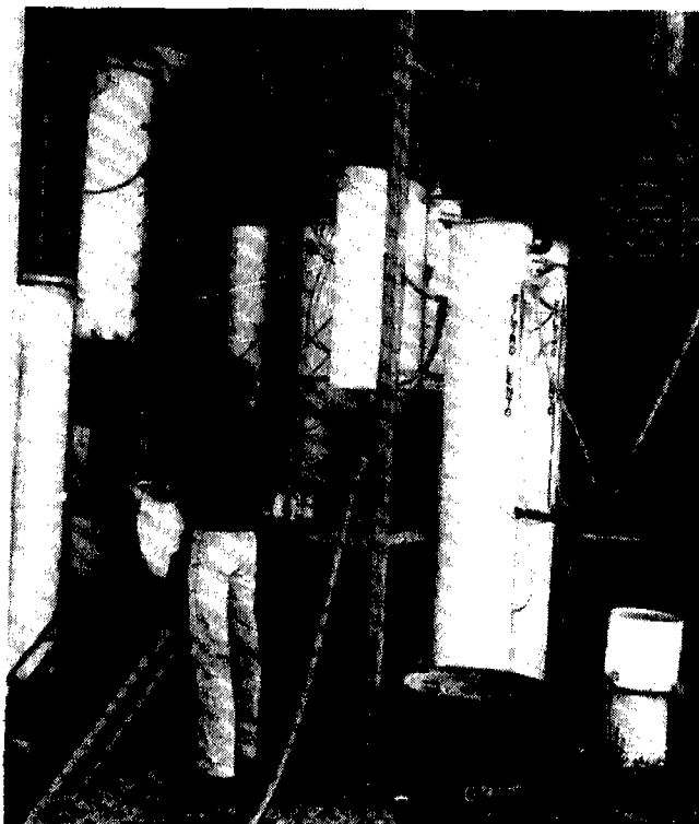
Figura No. 5. Planta Piloto: puerto Mallarino. Fuente: Río Cauca, predio planta Puerto Mallarino, Emcali, Colombia.
