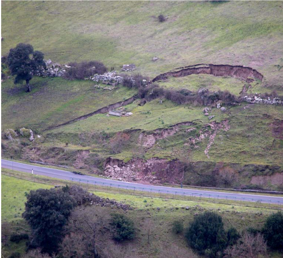
Figura 25.12 Fenomeni di scivolamento rotazionale a ridosso della strada provinciale Allai-Samugheo in Comune di Ruinas (OR).
