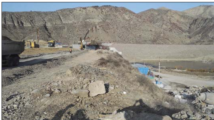
Obr. 2 Vyšší křídlo sypané přehradní hráze Fig. 2 The higher wing of the earthfill dam
