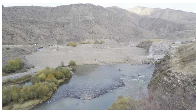
Obr. 3 Nižší, těsněné křídlo přehrady Fig. 3 The lower, sealed wing of the dam
