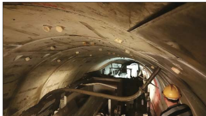
Obr. 10 Provádění výplňové injektáže – část cementace Fig. 10 Execution of back grouting – cementation
