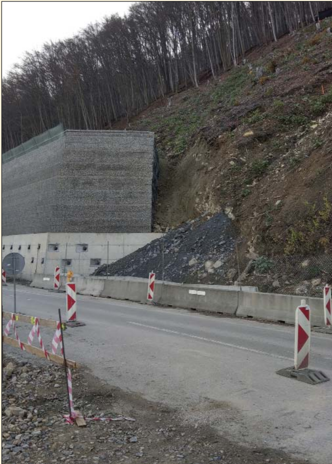
Obr. 3 Tunel Diel, východný portál Fig. 3 Diel tunnel, eastern portal
