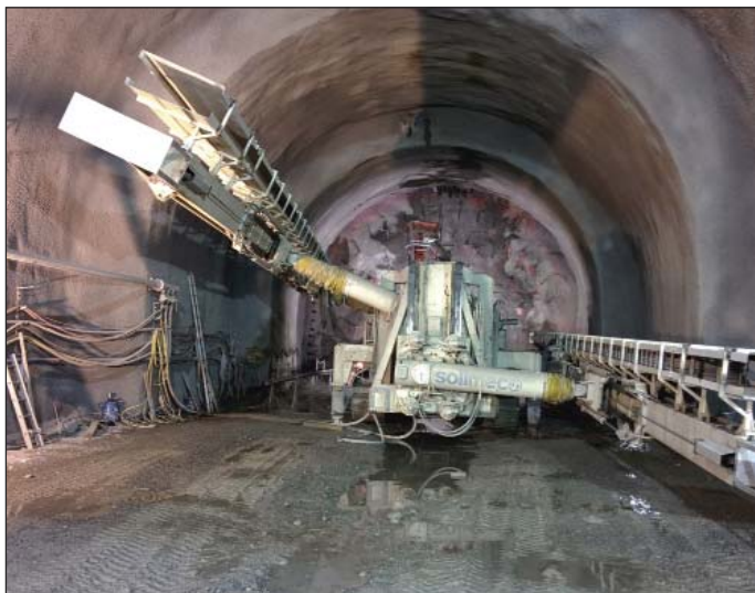
Obr. 2 Vrtacia súprava Soilmec ST 120 Fig. 2 Soilmec ST 120 drill rig
