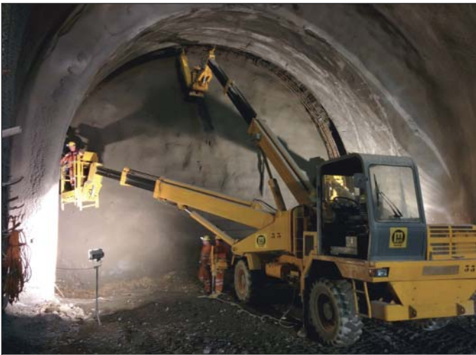
Obr. 6 Inštalácia priehradových oblúkov v klenbe Fig. 6 Installation of lattice arches in the upper vault
