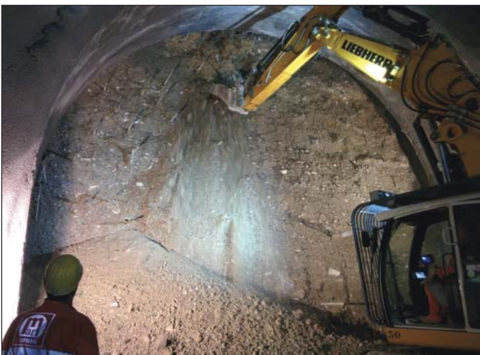
Obr. 5 Výlom tunela v stmelených štrkoch Fig. 5 Tunnel excavation through compacted gravel
