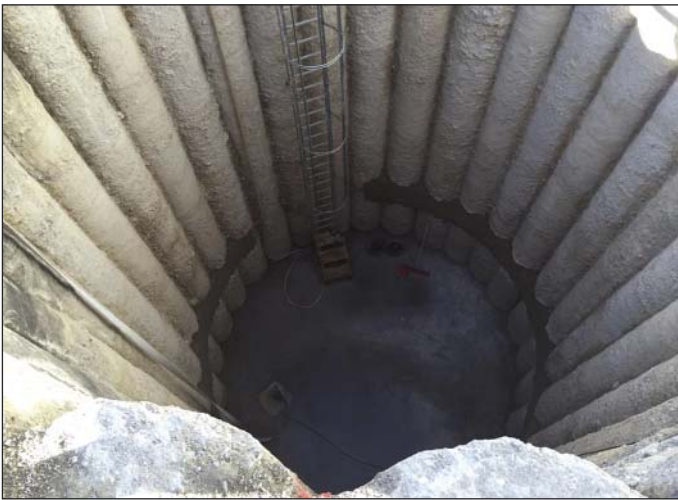
Obr. 9 Šachta s ostením z prevrtávaných pilot Fig. 9 Shaft with secant pile lining
