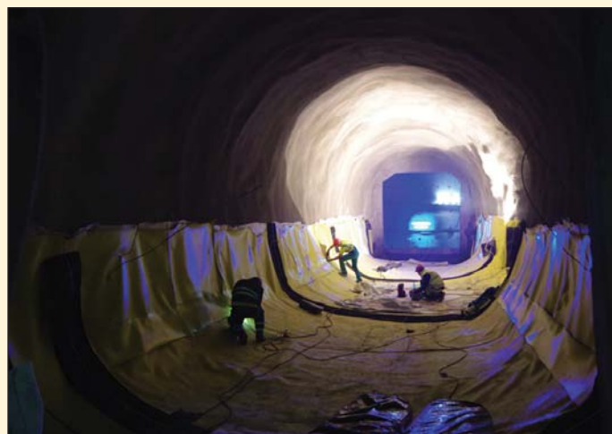
Obr. 1 Provádění hydroizolací v propojkách tunelu Ejpvovice
