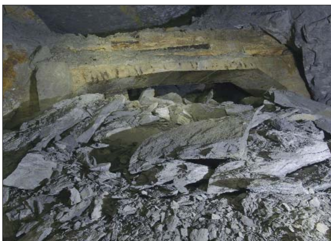
Obr. 9 Nedokončené zajištění v chodbě 15/5 Fig. 9 Unfinished excavation support in gallery 15/5
