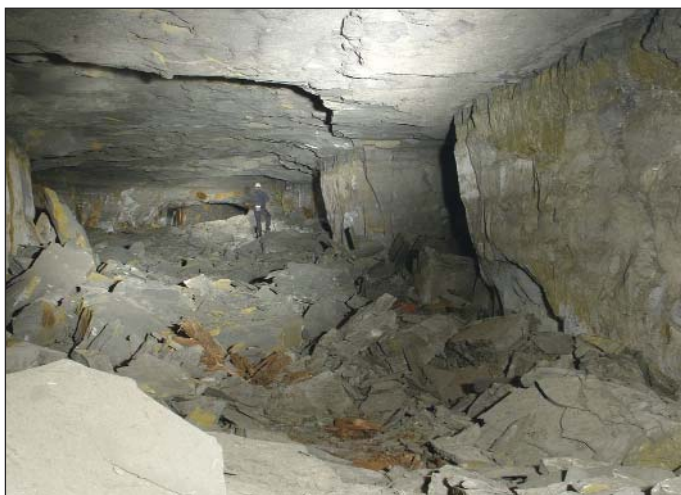
Obr. 3 Pohled do starých rozšířených a nezajištěných chodeb dolu Richard II. Fig. 3 A view down the old expanded and unsupported galleries of Richard II mine
