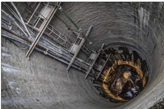
Obr. 1 Šachta J102 – dohloubení dojezdu šplhavého výtahu Fig. 1 Shaft J102 – completion of the excavation of the shaft pit for the mast climbing lift
