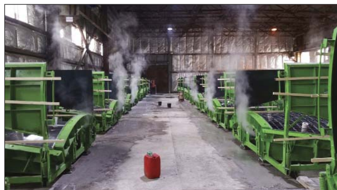
Obr. 14 Propařovací zkouška Fig. 14 Steam curing test
