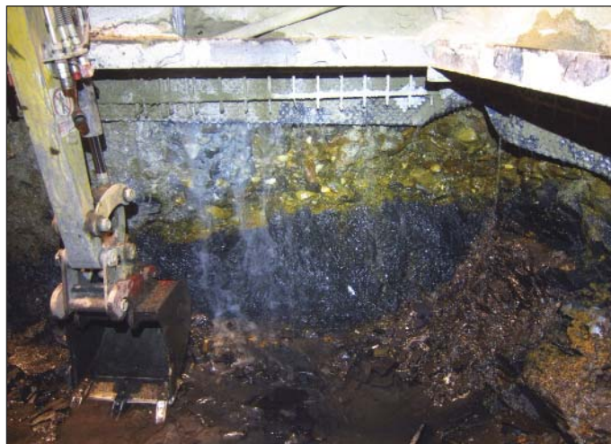
Obr. 7 Přechod ze šterků na bázi terasových sedimentů do zdravých břidlic v šachtě Š2 Fig. 7 Transition from gravel at the base of terrace sediments to fresh shale in shaft Š2
