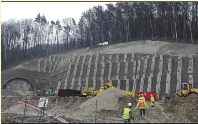
Obr. 4 Tunel Milochovo, západný portál Fig. 4 Milochovo tunnel, western portal
