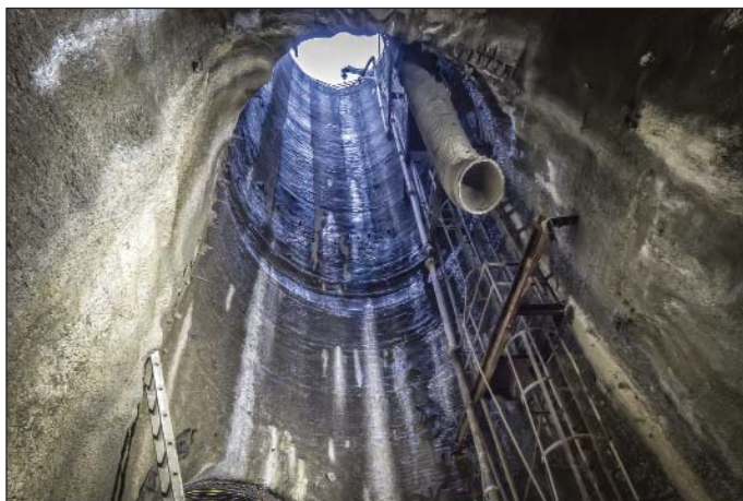
Obr. 6 Šachta J101 – primární ostění Fig. 6 Shaft J101 – primary lining
