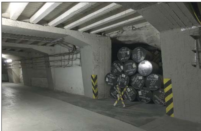
Obr. 2 Pohled do provozovaného úložiště RAO Richard a ukládacích komor Fig. 2 A view down the operating Richard RAW repository and disposal chambers
