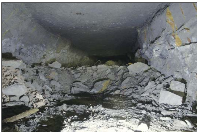
Obr. 8 Pohled do chodby č. 32 (současný stav) Fig. 8 A view down gallery No. 32 (current conditions)
