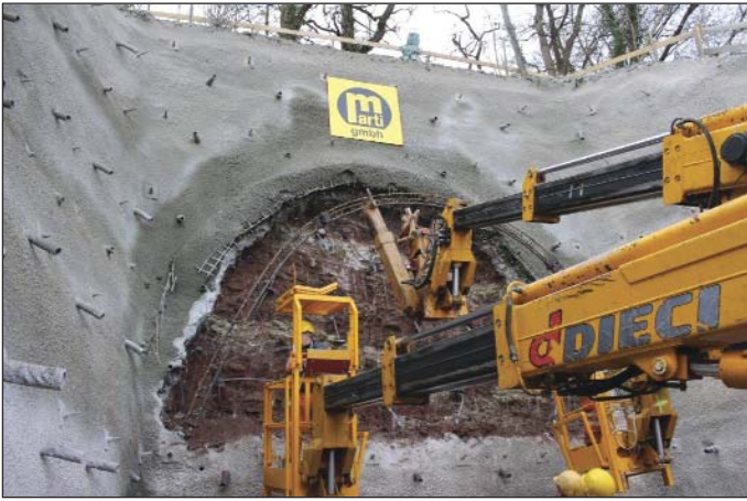
Obr. 4 Začatie razenia prístupovej štôlne Fig. 4 The beginning of driving the access tunnel
