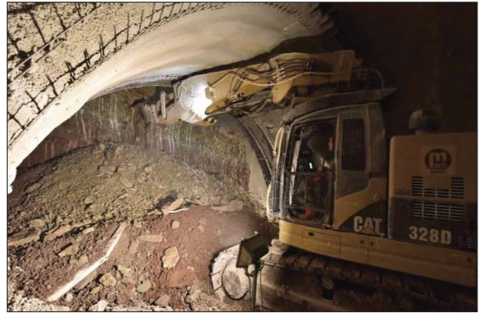
Obr. 5 Otváranie kaloty severnej tunelovej rúry pomocou tunelového bágra CAT 328D
