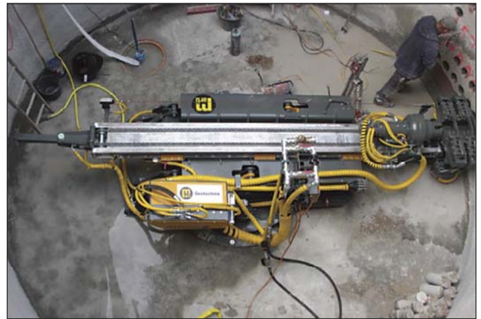
Obr. 10 Realizácia injektážnych prác v oblasti Gießenbach (hĺbené šachty a vrtanie injektážnych vrtov) Fig. 10 Realisation of grouting in the Gießenbach area (sunk shafts and drilling of grouting holes)
