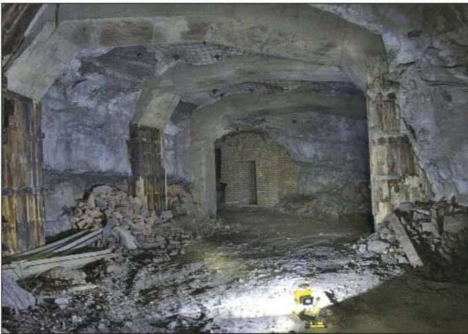
Obr. 10 Dopravní chodba č. 1 směrem k úložišti RAW
