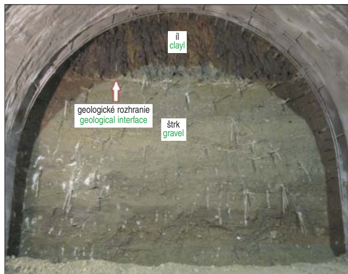
Obr. 3 Rozdelenie geologických vrstiev Fig. 3 Division of geologic layers
