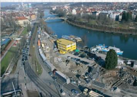
Cestný tunel Rosenstein, Nemecko
