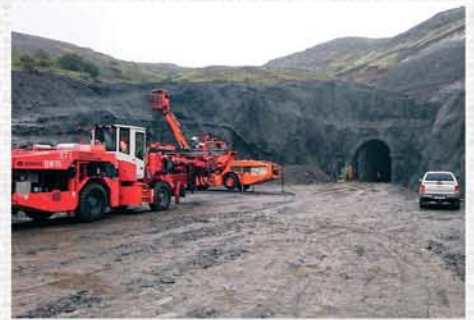
Podzemná vodná elektrárň Búrfell, Island
