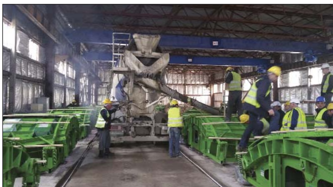
Obr. 13 Plnění segmentových forem Fig. 13 Filling the segment moulds
