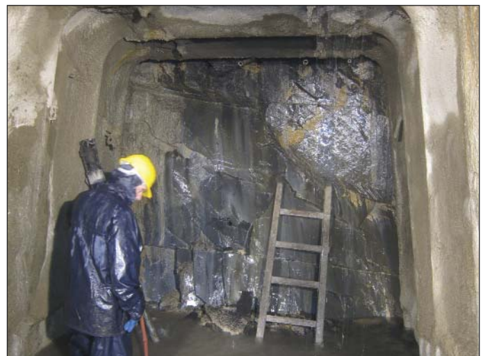
Obr. 5 Ražba spodní štoly
