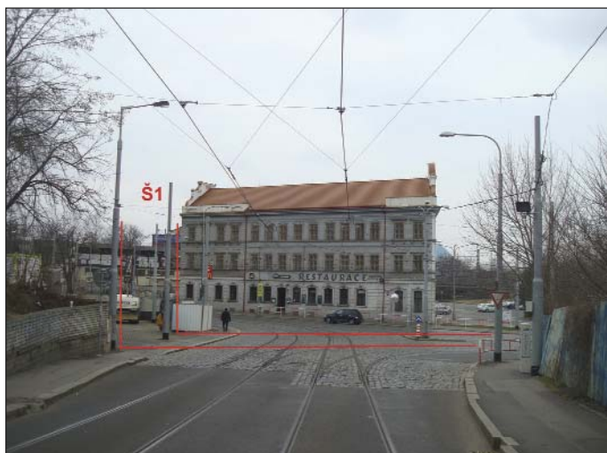
Obr. 1 Křižovátka Partyzánská – Na Zátorách pod níž proběhla ražba štoly Fig. 1 Intersection between Partyzánská and Na Zátorách streets, under which the gallery excavation passed
