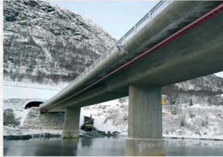
Cestný tunel Nordnes, Nórsko
