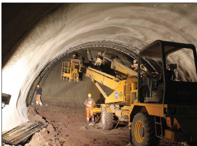
Obr. 10 Južná tunelová rúra – zaistovanie výrubu oblúkovým priehradovým nosníkom
