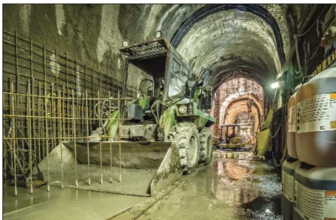
Obr. 4 Kolektorová trasa J102–J101 – primární ostění kolektoru k šachtě J102 Fig. 4 Utility tunnel route J102–J101 – primary utility tunnel lining toward shaft J102
