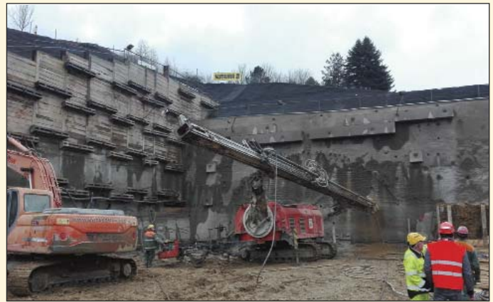
Obr. 5 Tunel Milochovo, východný portál Fig. 5 Milochovo tunnel, eastern portal
