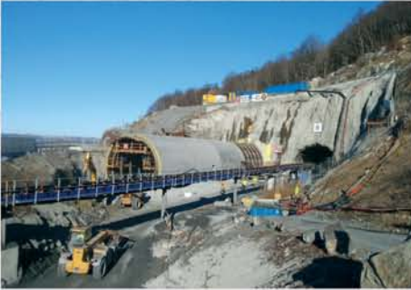
Cestný tunel Solbakk, Nórsko
