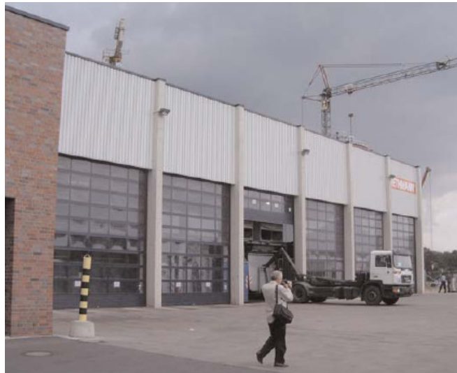
Σχήμα 3-24 Μονάδα ΜΒΕ στην Κολωνία, Γερμανία (Πηγή: DEFRA, 2005b).
