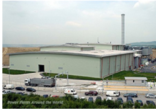
Σχήμα 3-37 Όψη της μονάδας αποτέφρωσης ΑΣΑ στο Allington Quarry.
