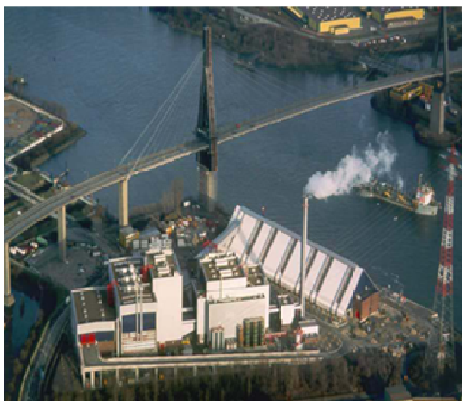
Σχήμα 3-36 Όψη της μονάδας αποτέφρωσης ΑΣΑ του Αμβούργου.
