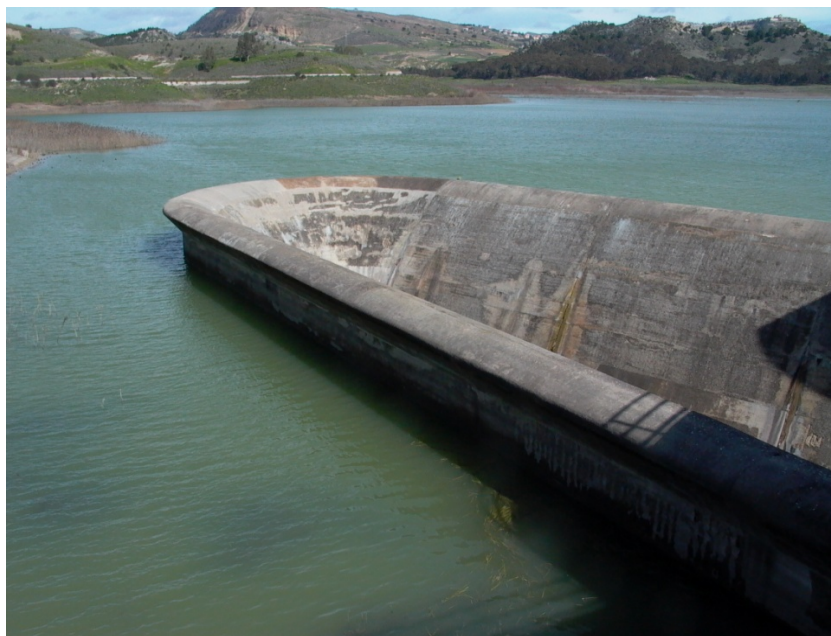
Fig. 22.21 - Diga Comunelli - Scarico di superficie sagomato a barca con profilo della soglia Creager-Scimemi (Foto C. Gambino, 2009).
