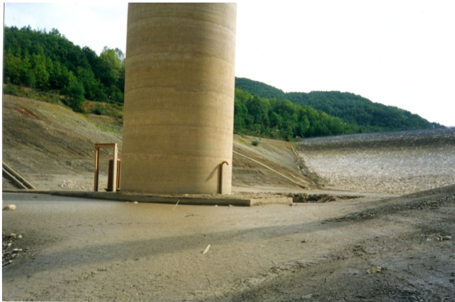
Figura 22.23: diga Carmine - fondo del serbatoio con evidenza delle opere di scarico e di presa
