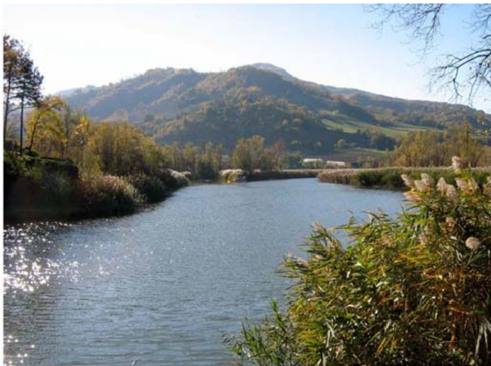
Figura 22.3 - Veduta d'insieme dell'estensione del canneto sviluppatosi nella zona prospiciente lo sbarramento
