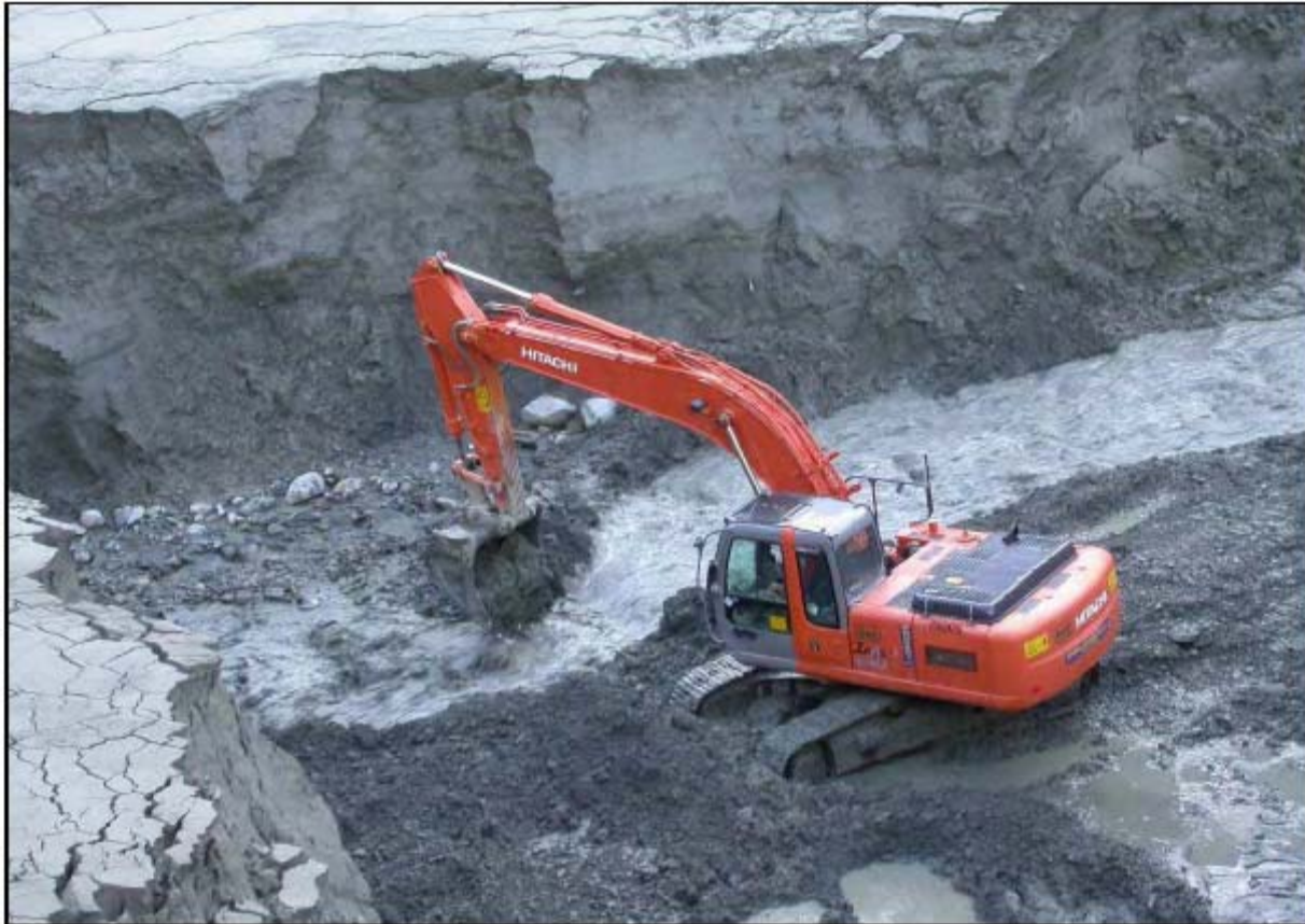
Figura 22.34 - rimozione del sedimento coadiuvata da mezzi meccanici.
