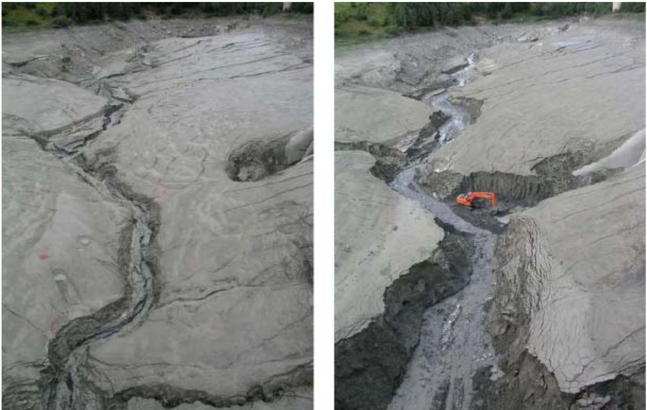
Figura 22.33 - il fondo del bacino di Valgrosina all'inizio e alla fine delle operazioni di fluitazione; a sinistra il secondo giorno (29 agosto 2006) a destra l'ultimo giorno (9 settembre 2006).
