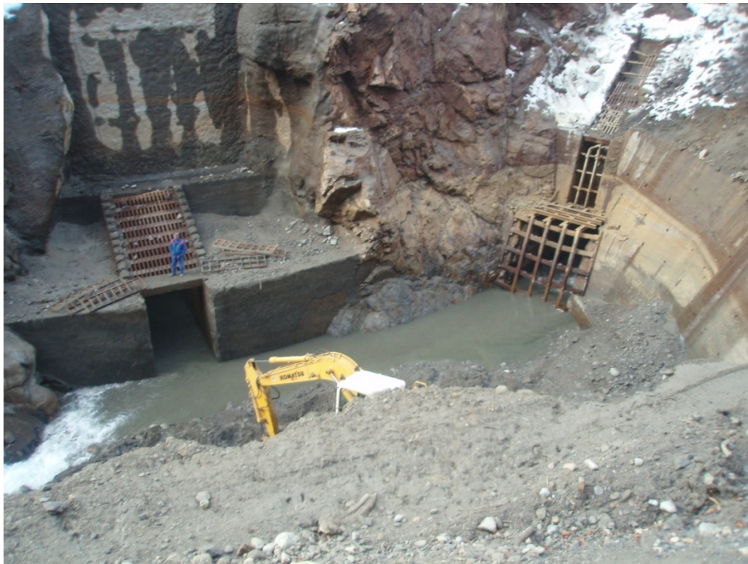
Figura 22.15: Serbatoio di Campo Tartano – Disinterro imbocco scarichi
