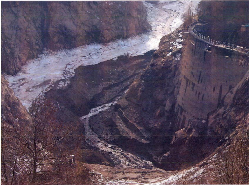
Figura 22.14: Serbatoio di Campo Tartano – Stato dell'interrimento
