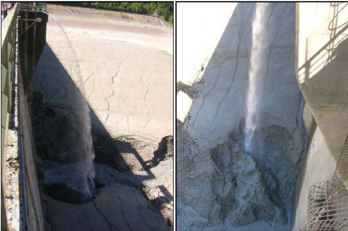
Figura 22.32 - utilizzo di getti d'acqua per erodere il materiale addossato agli scarichi di esaurimento.
