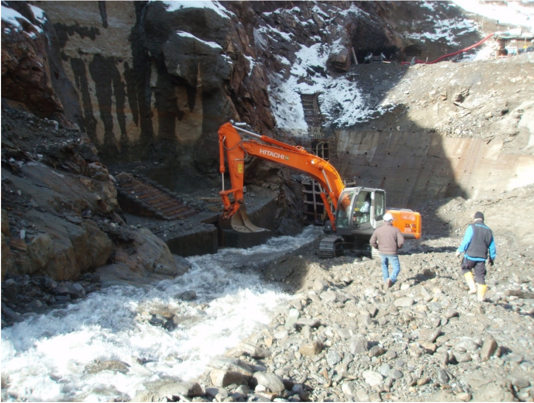
Figura 22.16: Serbatoio di Campo Tartano – Disinterro imbocco scarichi
