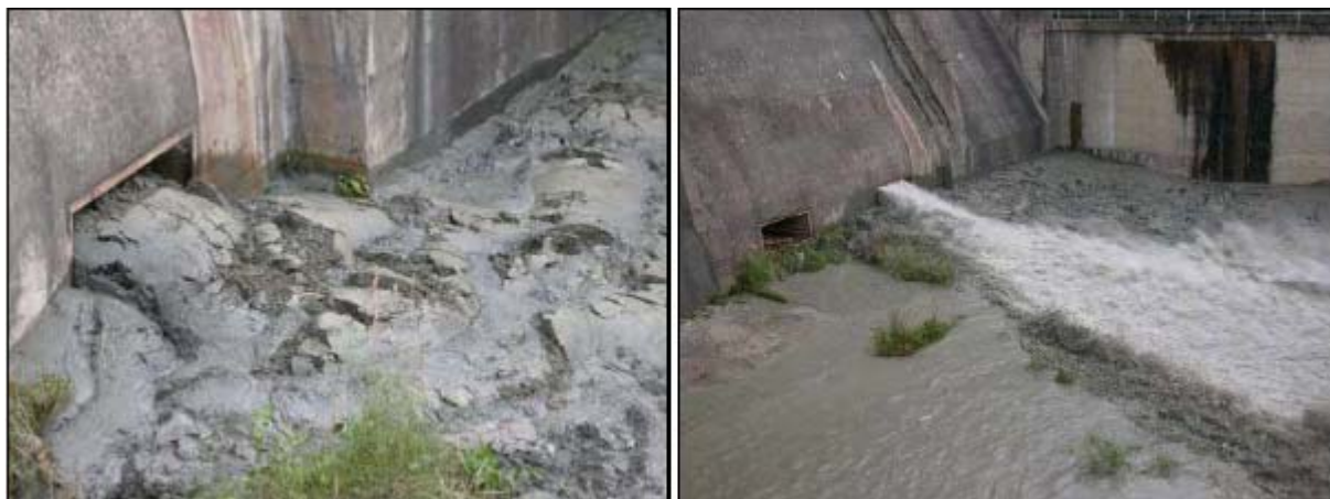
Figura 22.43 - fuoriuscita del sedimento e dell'acqua residua presente nel bacino dallo scarico di esaurimento.
