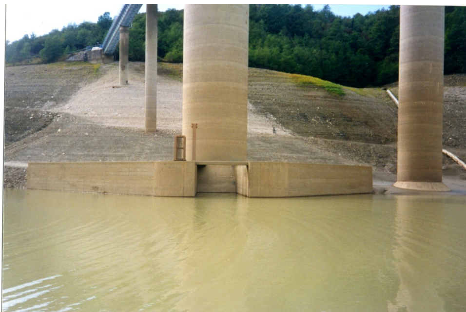
Figura 22.22: diga Carmine - fondo del serbatoio con evidenza delle opere di scarico e di presa
