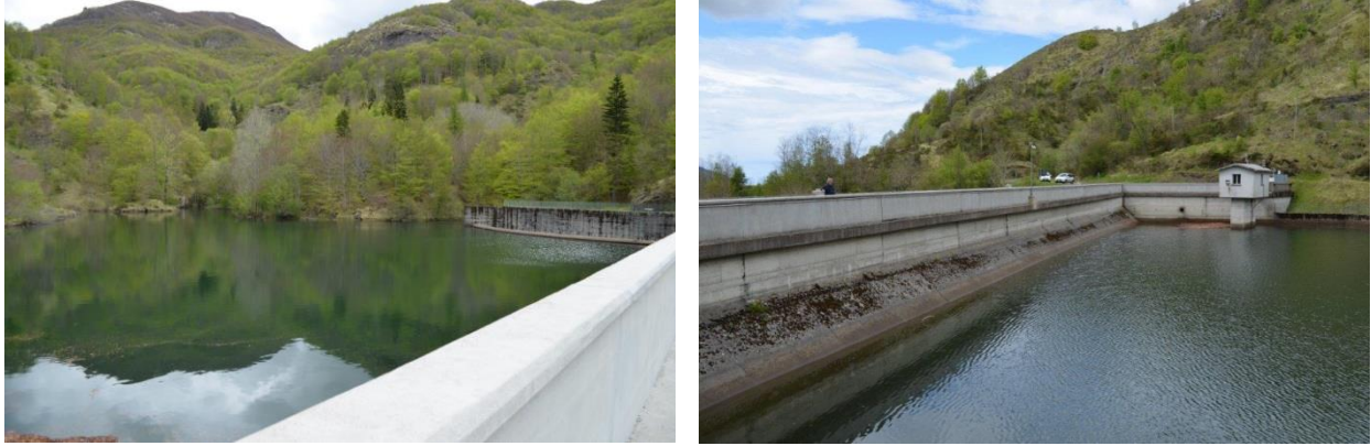
La diga di S. Maria del Taro: vista dell'invaso e del locale di guardia
