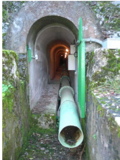
Dispositivi antintrusione – Recinzione del perimetro bacino e accesso allarmato al cunicolo ispezione e raccolta drenaggi
