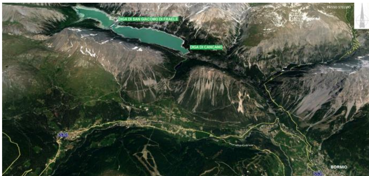
Inquadramento delle dighe di Cancano e San Giacomo di Fraele in alta Valtellina (immagine satellitare)
