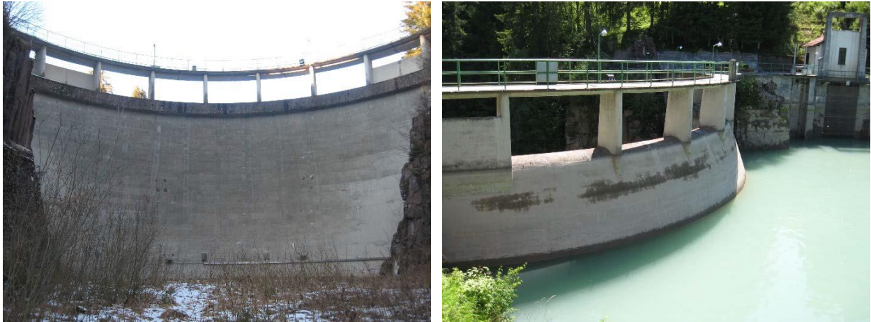
Diga di Pezzè di Moena (vista da valle e da monte)
