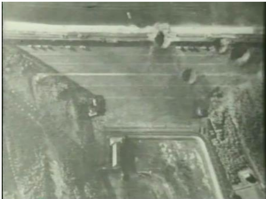
Figura 2 - Gli effetti dell'attacco portato alla diga di Sorpe
