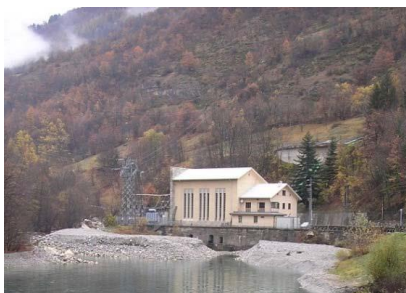
Vista dalla diga della centrale (casa di guardia) di Fedio in coda al lago
