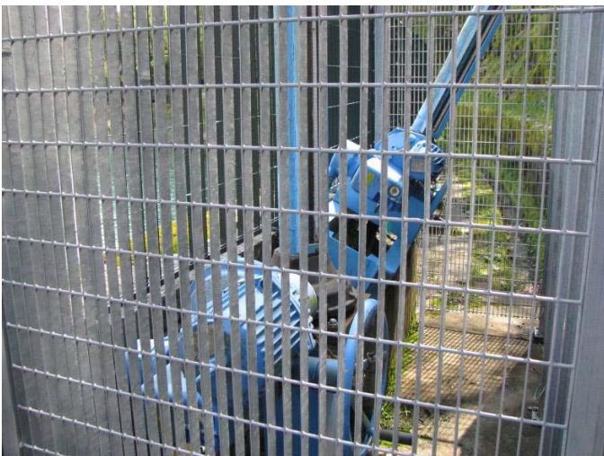
Dispositivi antintrusione – Schermatura metallica dei dispositivi di manovra
