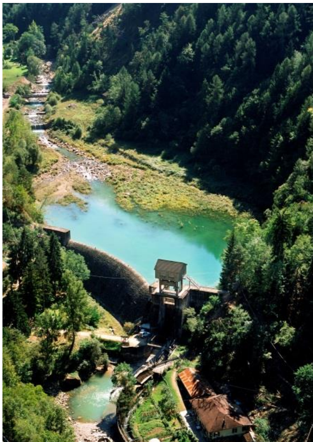
Diga della val d'Ega
