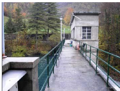
Locale di manovra scarico fondo: vista dalla sponda destra.
