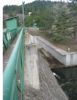
Sistema di sorveglianza – telecamera per osservazione paramento di valle, scarico di fondo e alveo a valle diga
