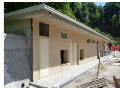
Nuovo locale polifunzionale per collocazione nuovo GE
