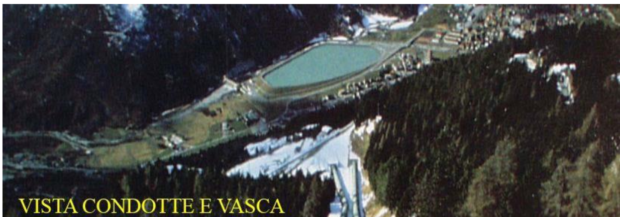
Vista aerea della vasca di Edolo e delle condotte forzate
