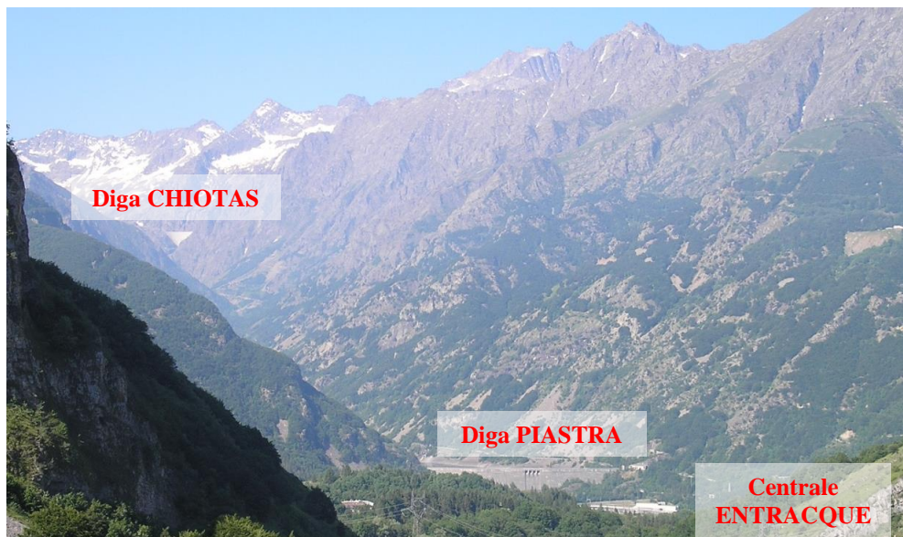
Vista della centrale di Entracques e delle dighe di Chiotas e Piastra
