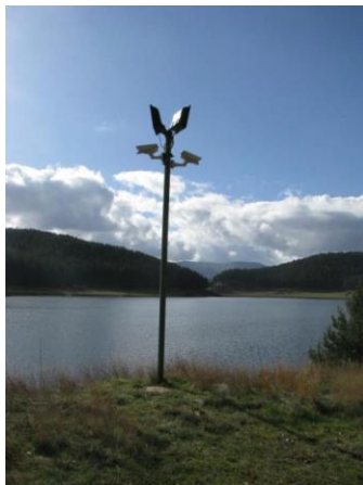
Sistema di sorveglianza – telecamere per osservazione paramento di monte e opera di presa, accesso principale
