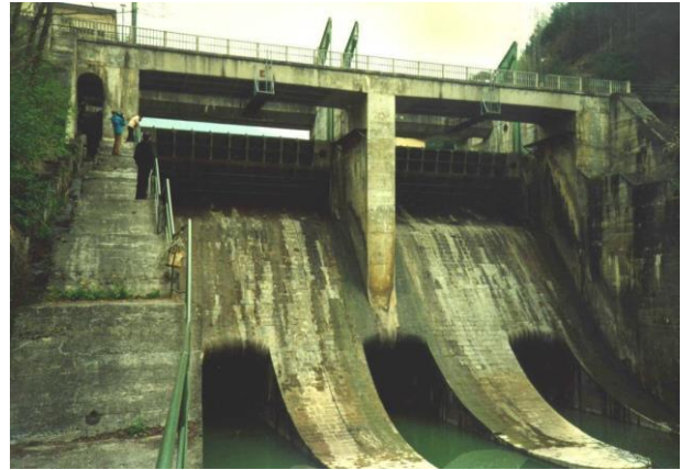
Diga di Rio Pusteria
