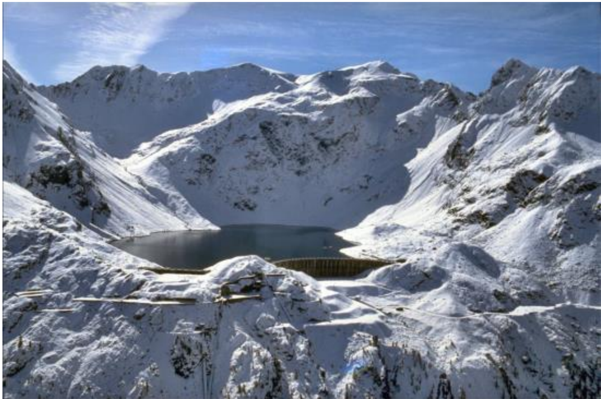
Diga di Publino
