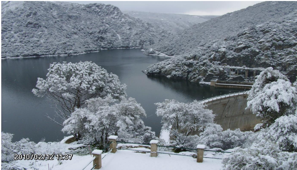
Diga sul Flumendosa a Nuraghe Arrubiu - vista dalla sponda destra
