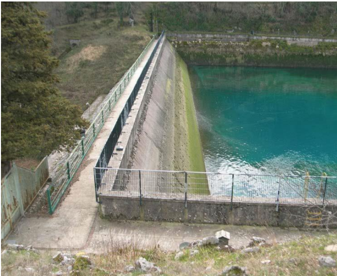
Dispositivi antintrusione – Recinzione del perimetro bacino e accesso allarmato al cunicolo ispezione e raccolta drenaggi
