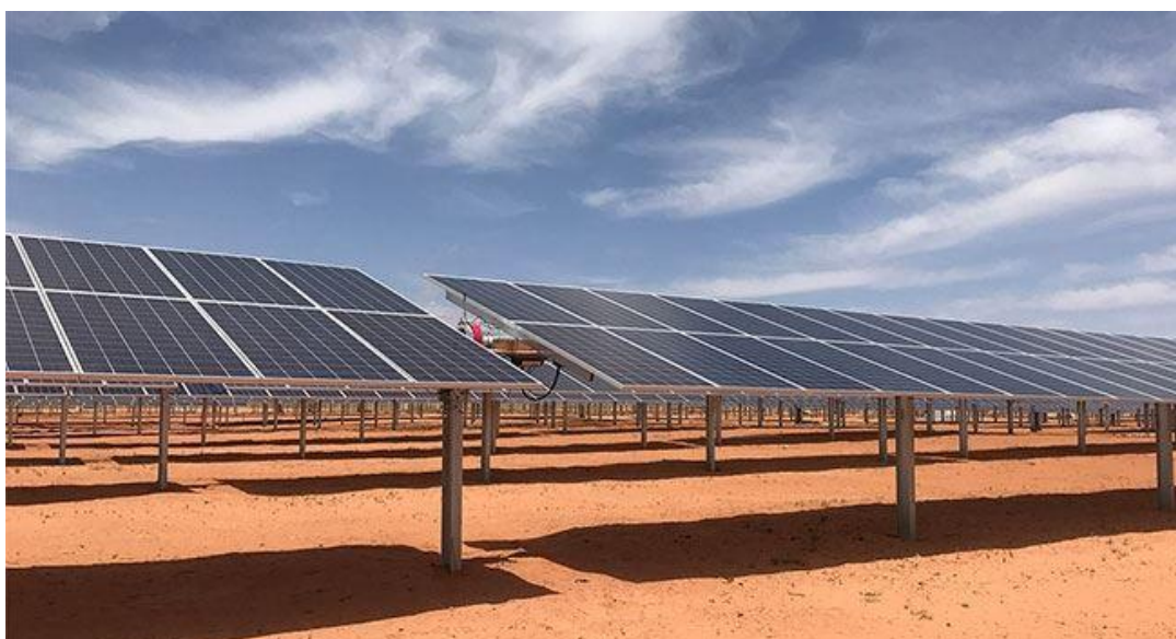
Foto de una planta con estructura hincada mediante pilotes
