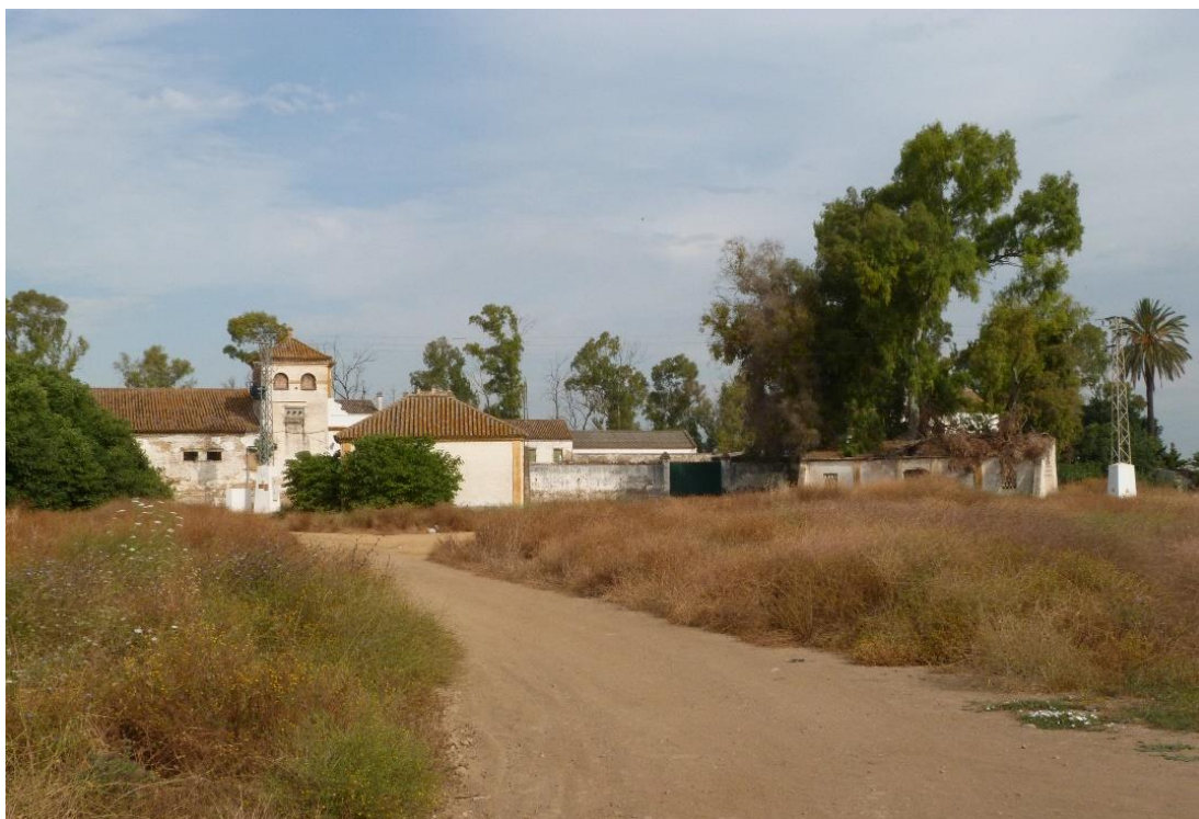
Vista del cortijo de Gambogaz, cuya torre posee protección patrimonial
