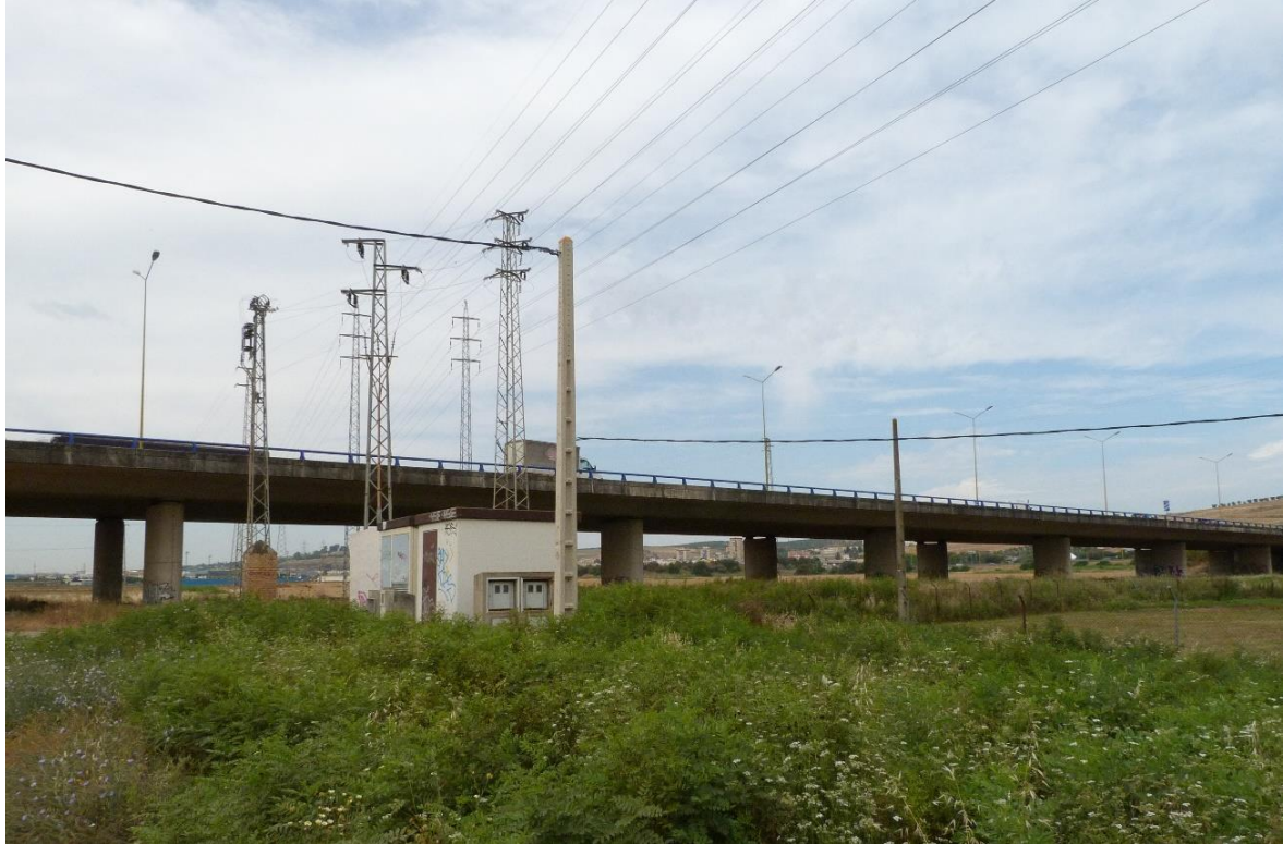
Infraestructuras diversas en las inmediaciones del cordel de Gambogaz.
