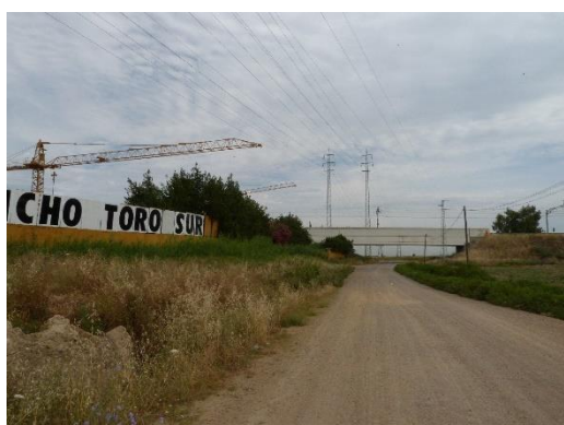
D. SE 30 a viaducto de ffcc
