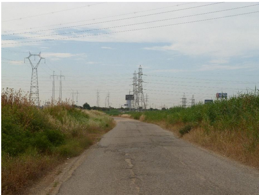
Acumulación de infraestructuras eléctricas y otros elementos disonantes
