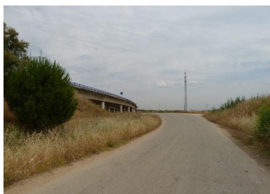
E. Viaducto A66
