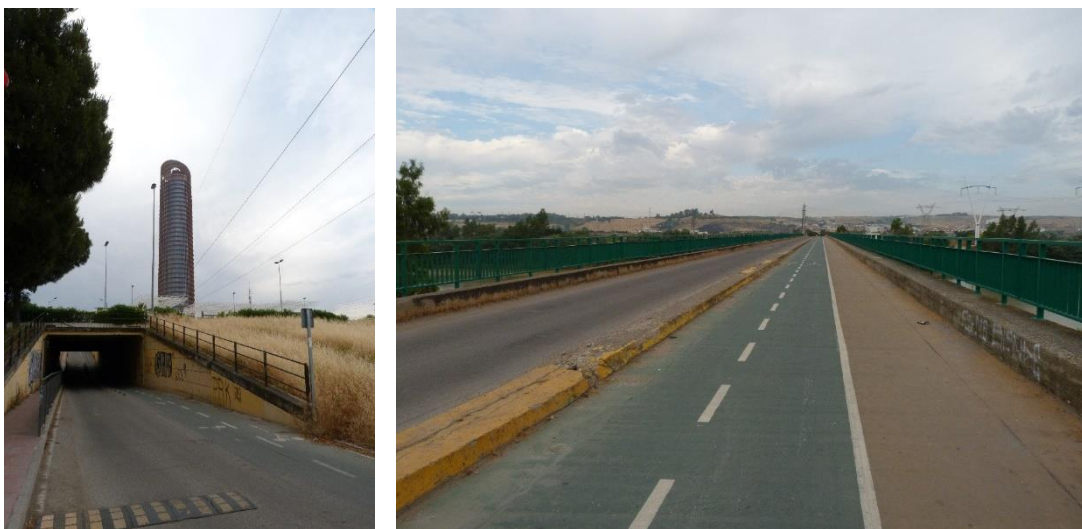
A. Proximidades de la Torre de Triana y Puente de la Señorita
