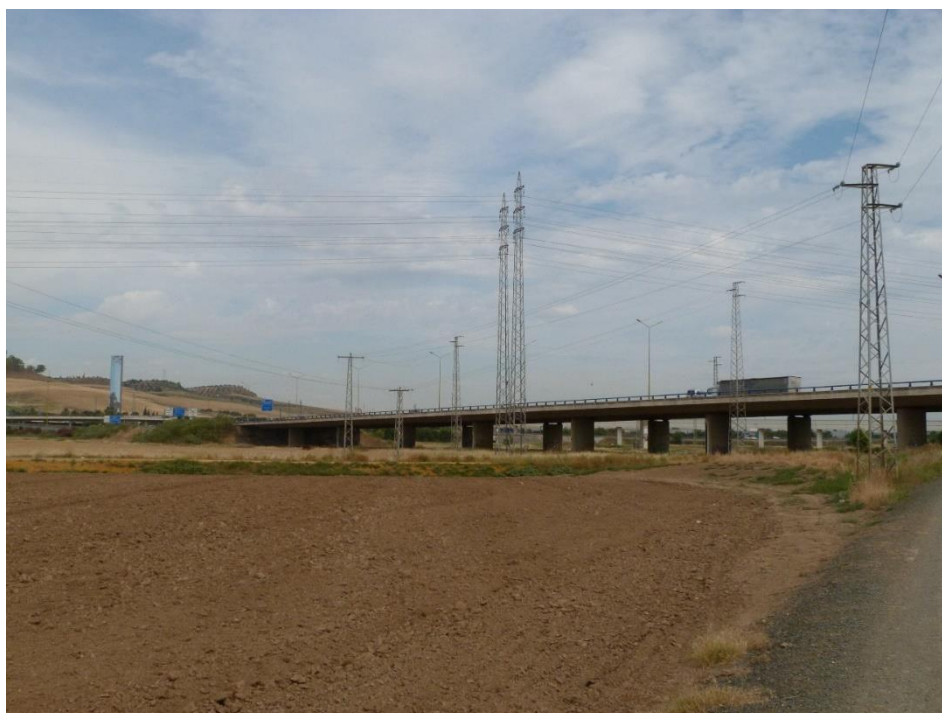
Vista del paso elevado de la SE-30 (viaducto de Itálica) desde el cordel de Gambogaz
